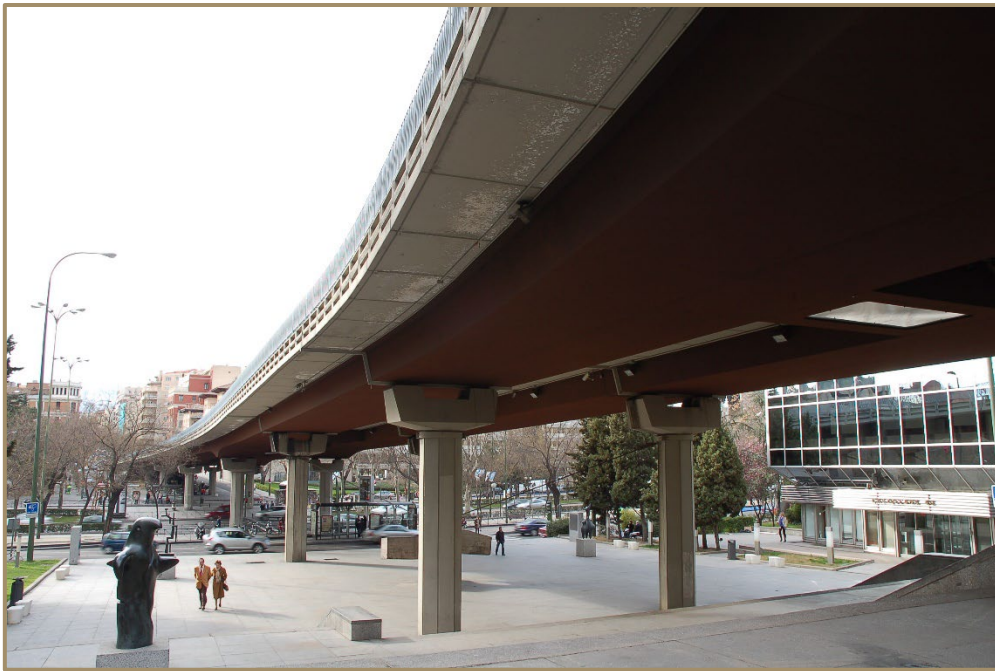
Imagen 18. Vista general del Puente de Juan Bravo - Eduardo Dato
