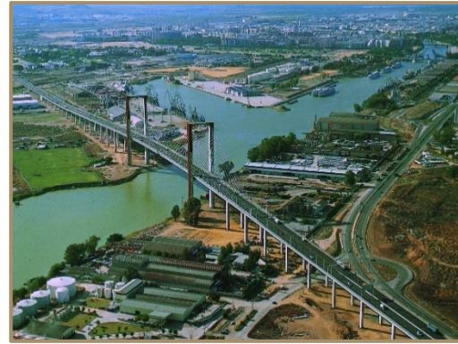
Imagen 40. Vista global donde se aprecian las columnatas
