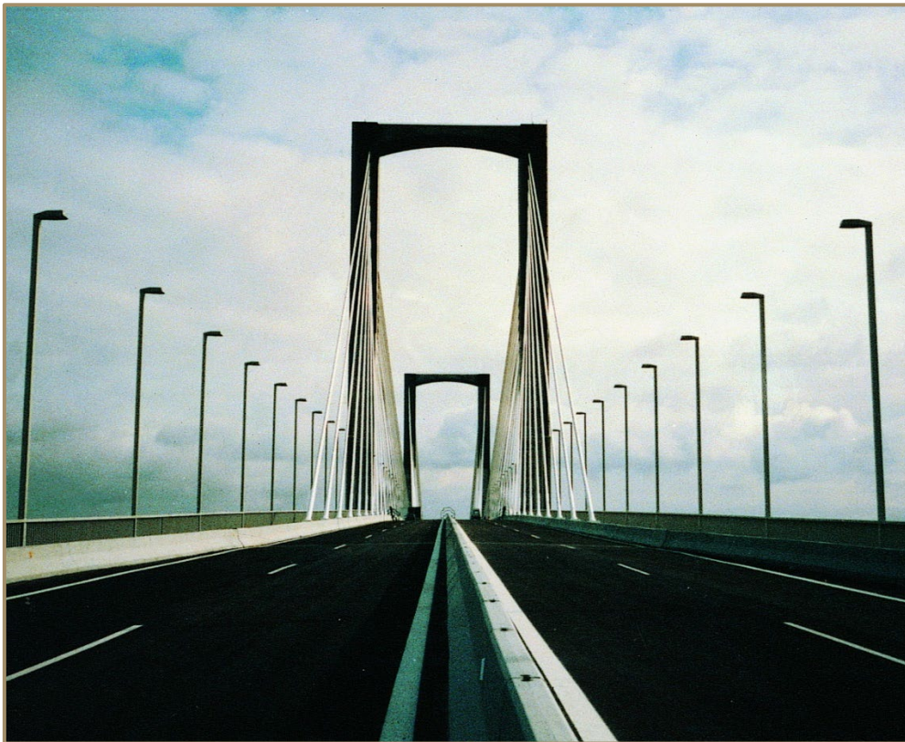
Imagen 38. Vista sobre el puente
