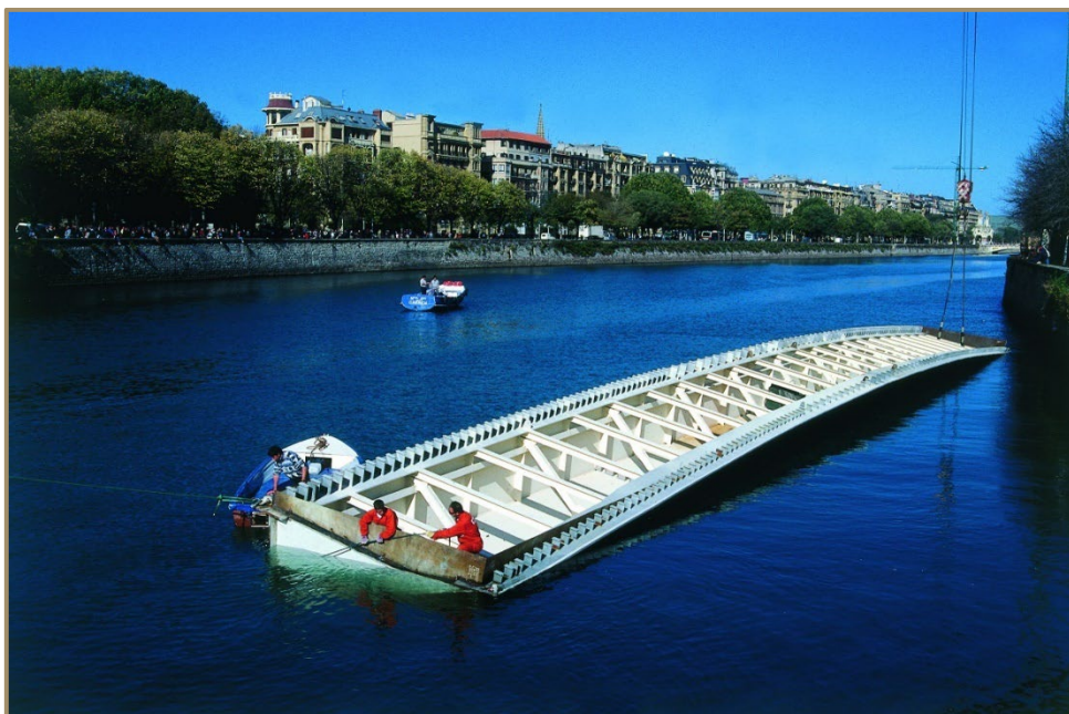
Imagen 47. Flotación del tramo central
