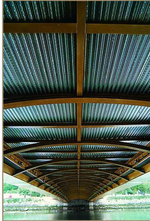
Imagen 52. Parte inferior, donde se puede ver su estructura
