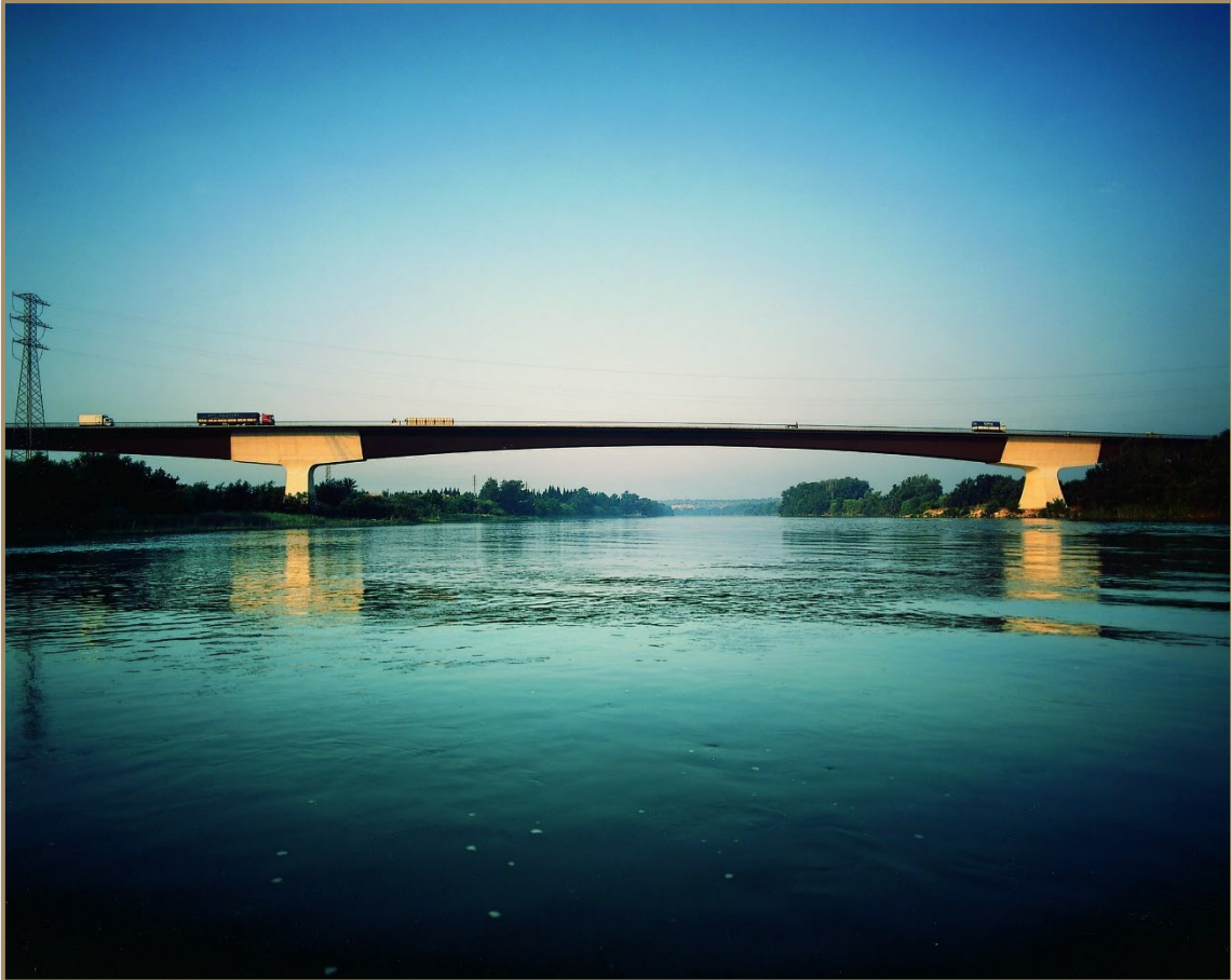
Imagen 29. Vista general del Puente del Milenario
