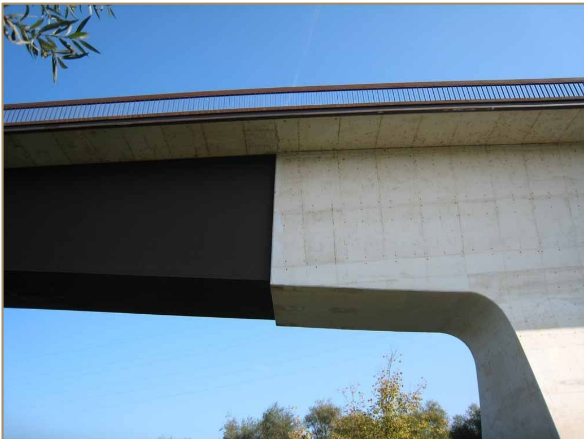
Imagen 31. Detalle del encuentro fuste-dintel
