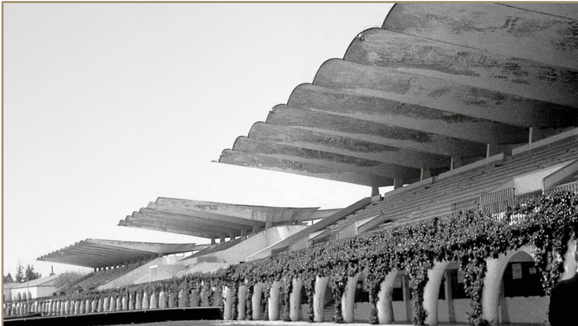
Imagen 4. Cubierta del hipódromo de la Zarzuela (1941), por Torroja
