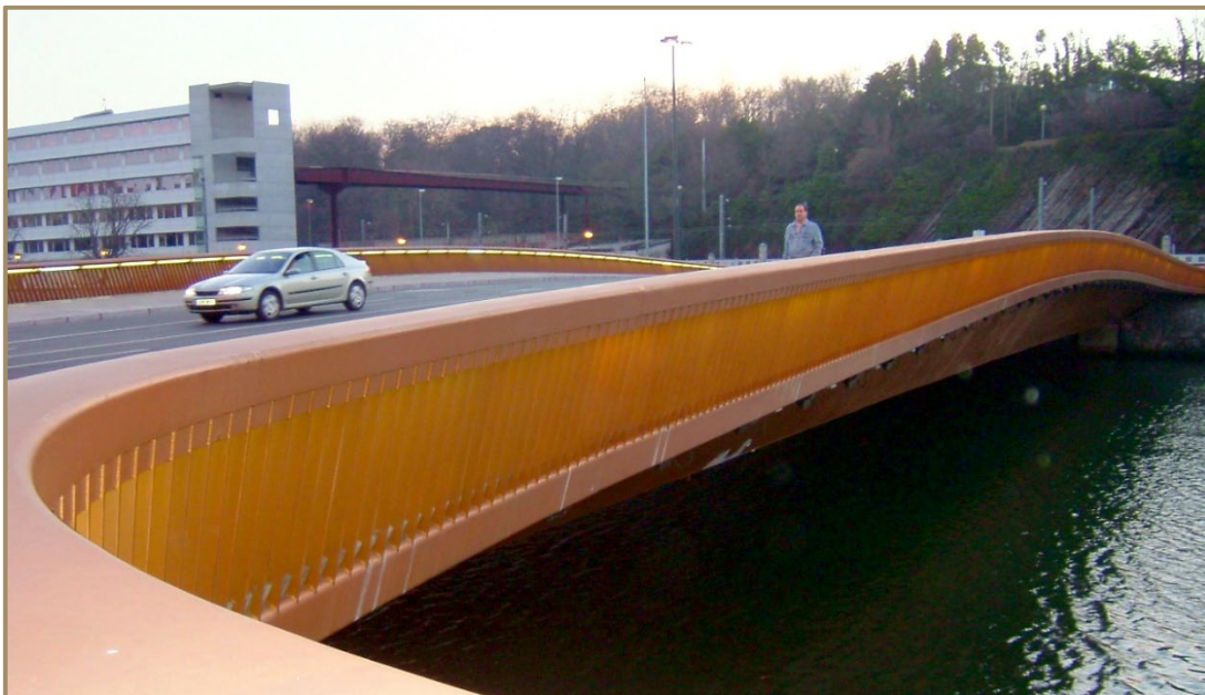
Imagen 50. Detalle de la barandilla
