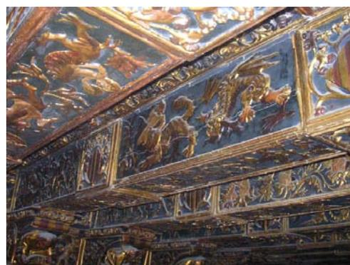
256.- Detalle de la estructura en su parte decorada. Las vigas forradas con las planchas policromadas.
