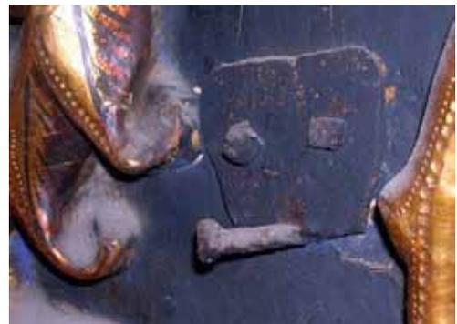
112.- Ejemplo de clavos de hierro forjado originales del siglo XV, con la plancha de refuerzo para hacer más presión. Este tipo de planchas suelen ser de cobre y normalmente las encontramos en las piezas de mayor tamaño.
