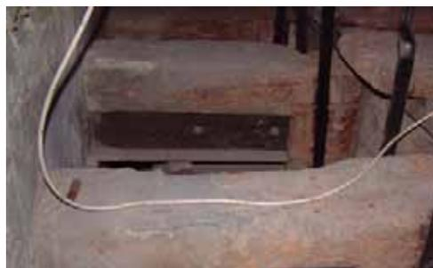
257.- Detalle de las cabezas de las vigas con los perfiles UPN-180 de acero y el empotramiento en el muro.
