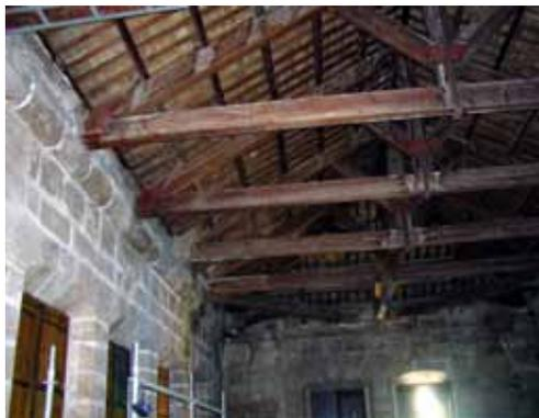
70.- Cubierta de la *loggia*, resuelta con 3 faldones de tablero de rastrilla apoyado sobre correas de madera, empotrada en los muros de cerramiento.
