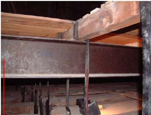
92.- Vigas metálicas (IPN-300). Elemento auxiliar de doble atirantado.
