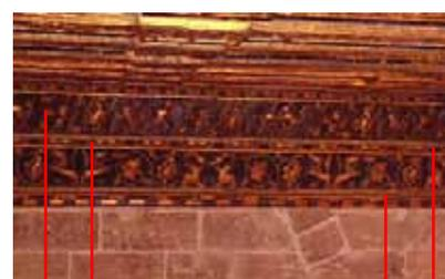
50.- Moldura convexa de sección semicilíndrica.
