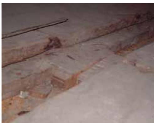
113.- Colocación de las planchas y marcas en la madera, creadas por los carpinteros artesanos, posiblemente para controlar el tajo o la numeración de las planchas.
