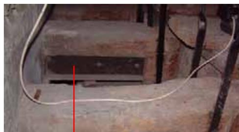
119.- Cabeza de la viga, donde observamos la reducción para insertar los perfiles IPN-180. Está en los dos lados de la viga.
