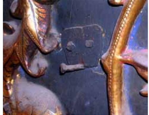
272.- Uno de los clavos de forja originales donde se puede observar la plancha metálica (cobre) para hacer más presión. Suelen aparecer en las planchas de mayor tamaño.
