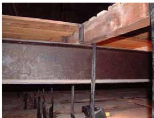
67.- Detalle del sistema de entarimado que tiene el pavimento del cuerpo superior de la planta primera. Actual segunda planta.
