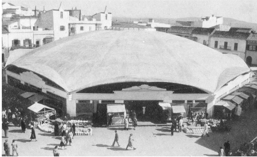
Figura 44 Cubierta del mercado de Algeciras, Cádiz 1935. Eduardo Torroja Miret
