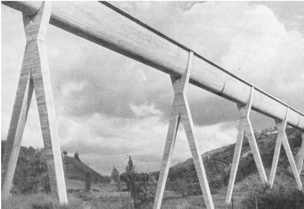
Figura 45 Acueducto de Allos. Navarra, 1939. Eduardo Torroja Miret
