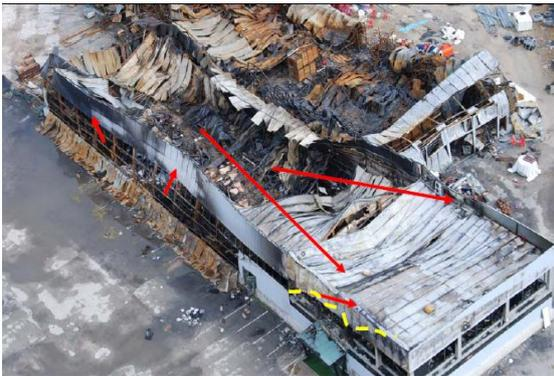
**Ilustración 40. Caída de la cubierta nave 2**
