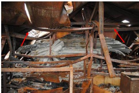
**Ilustración 44. Afectación en los materiales de la nave 1**
