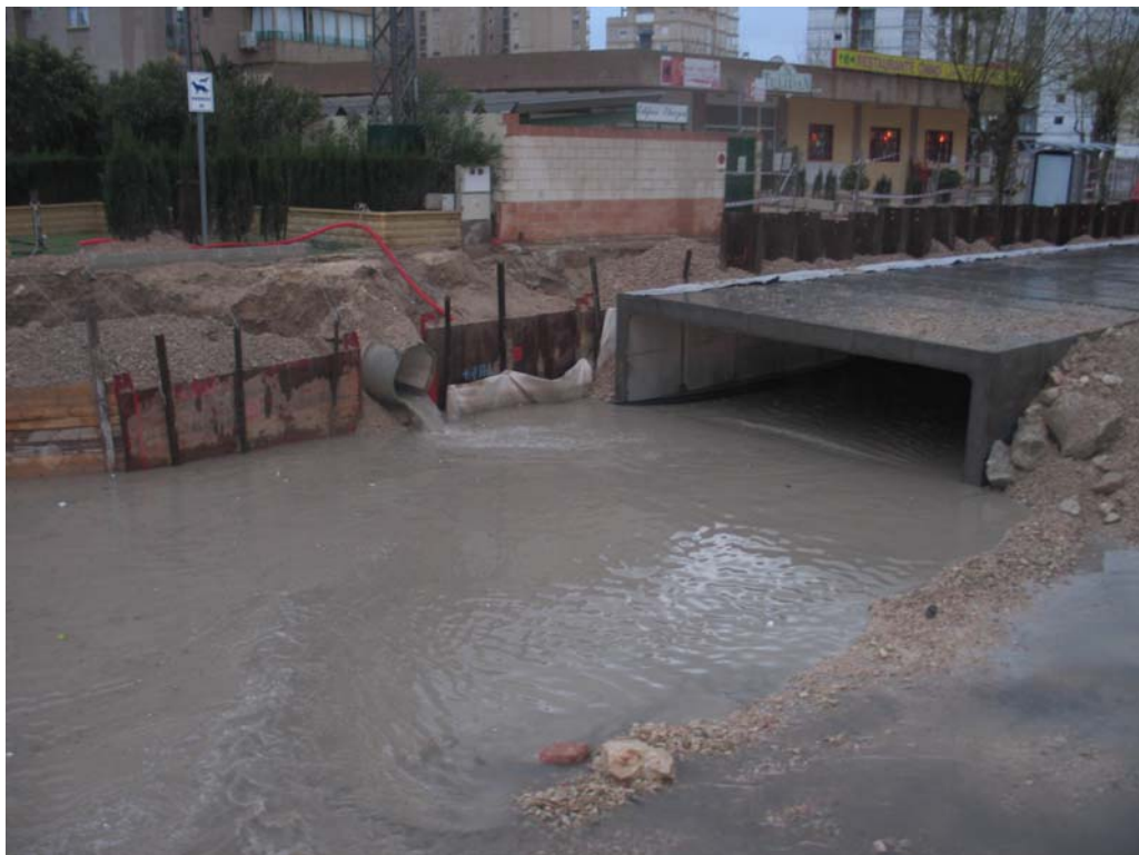
Figura IX-4. Tramo del principio de la ampliación del canal la tarde del 30 de marzo del 2009.
