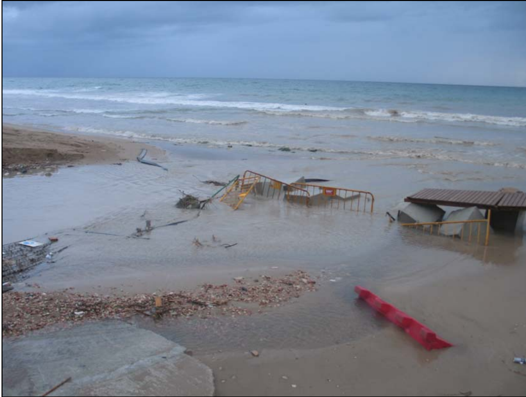
Figura IX-7. Efectos de la desembocadura al mar de la canalización la tarde del 30 de marzo del 2009.
