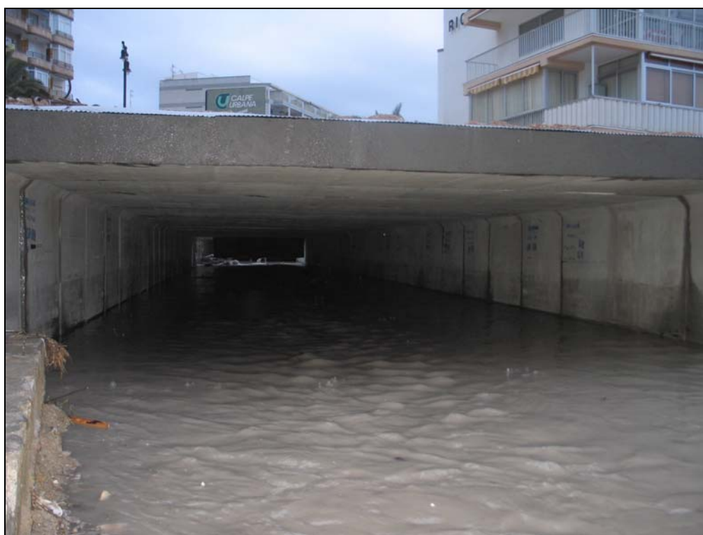
Figura IX-6. Tramo final de la ampliación del canal la tarde del 30 de marzo del 2009.
