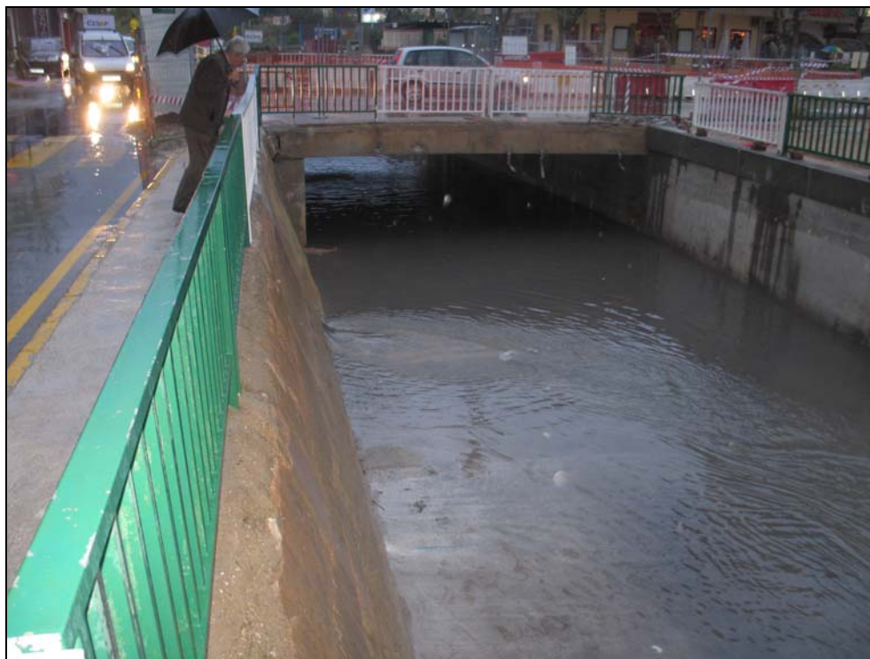
Figura IX-5. Tramo medio de la ampliación del canal la tarde del 30 de marzo del 2009.
