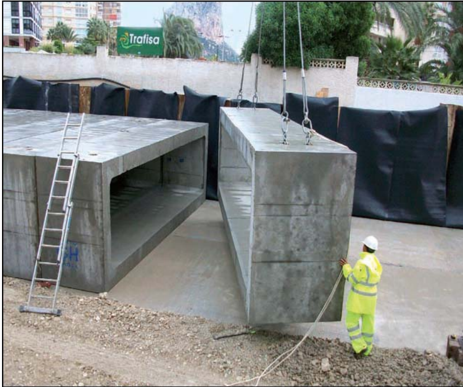
Figura VII-4. Fotografía de la colocación de los marcos prefabricados, extraída del libro “Lluvias Octubre 2007” de la Confederación Hidrográfica del Júcar.
