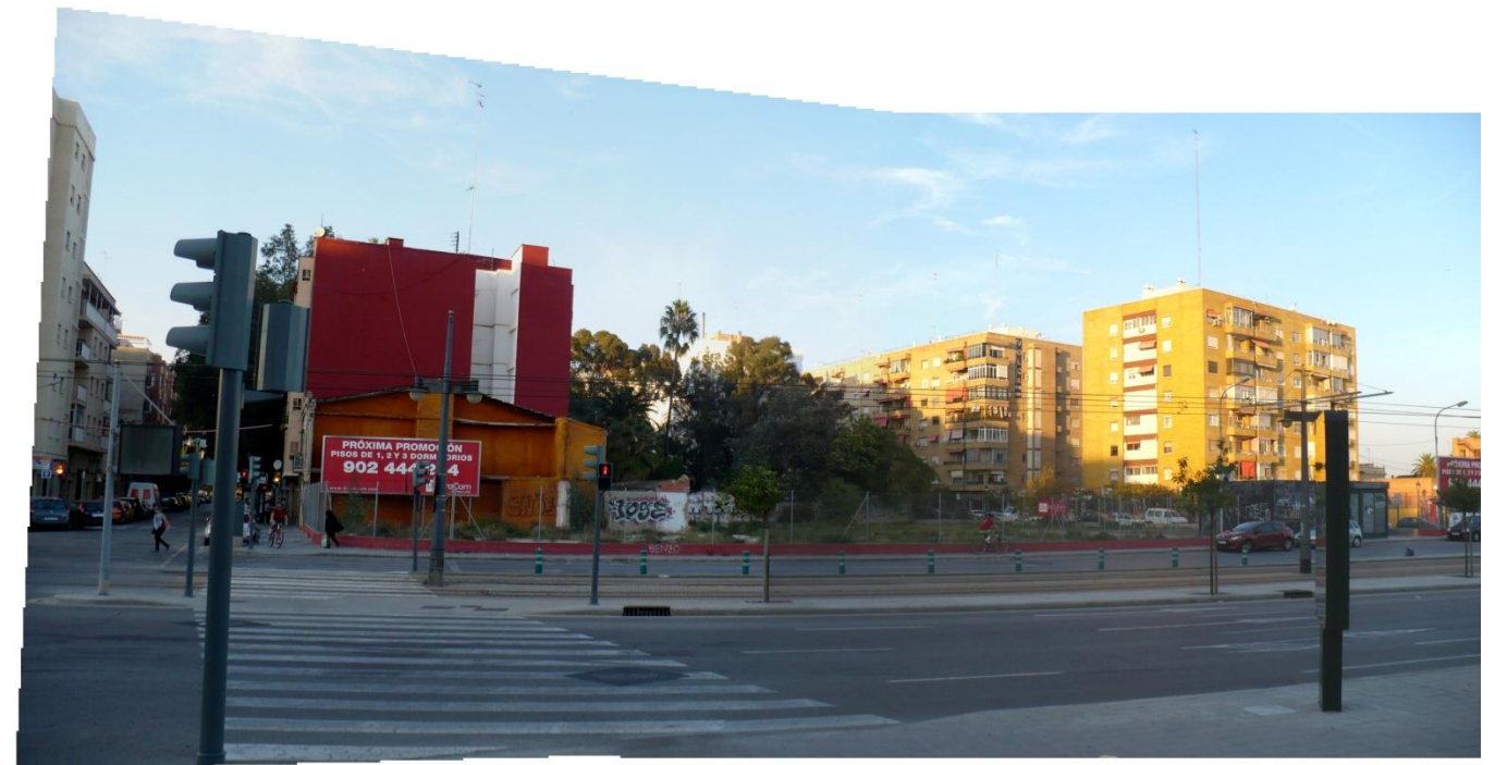
Lateral de la avenida de Tarongers
