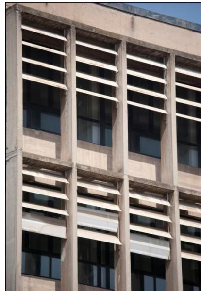
El "Brise soleil" es un elemento de la fachada que consiste en colocar una serie de baldas en el marco de una entrada de luz, cuya particular disposición evita que el ángulo de incidencia del sol en verano sobre caliente la fachada, al tiempo que favorece una entrada de luz homogénea.
