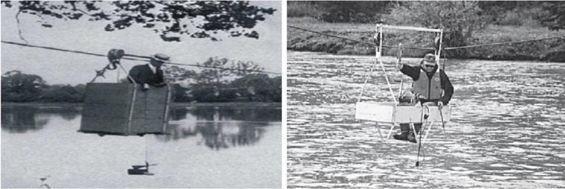
Figura 2.22 Aforo con molinete en 1909 y 1996 (Hauet, 2006)
