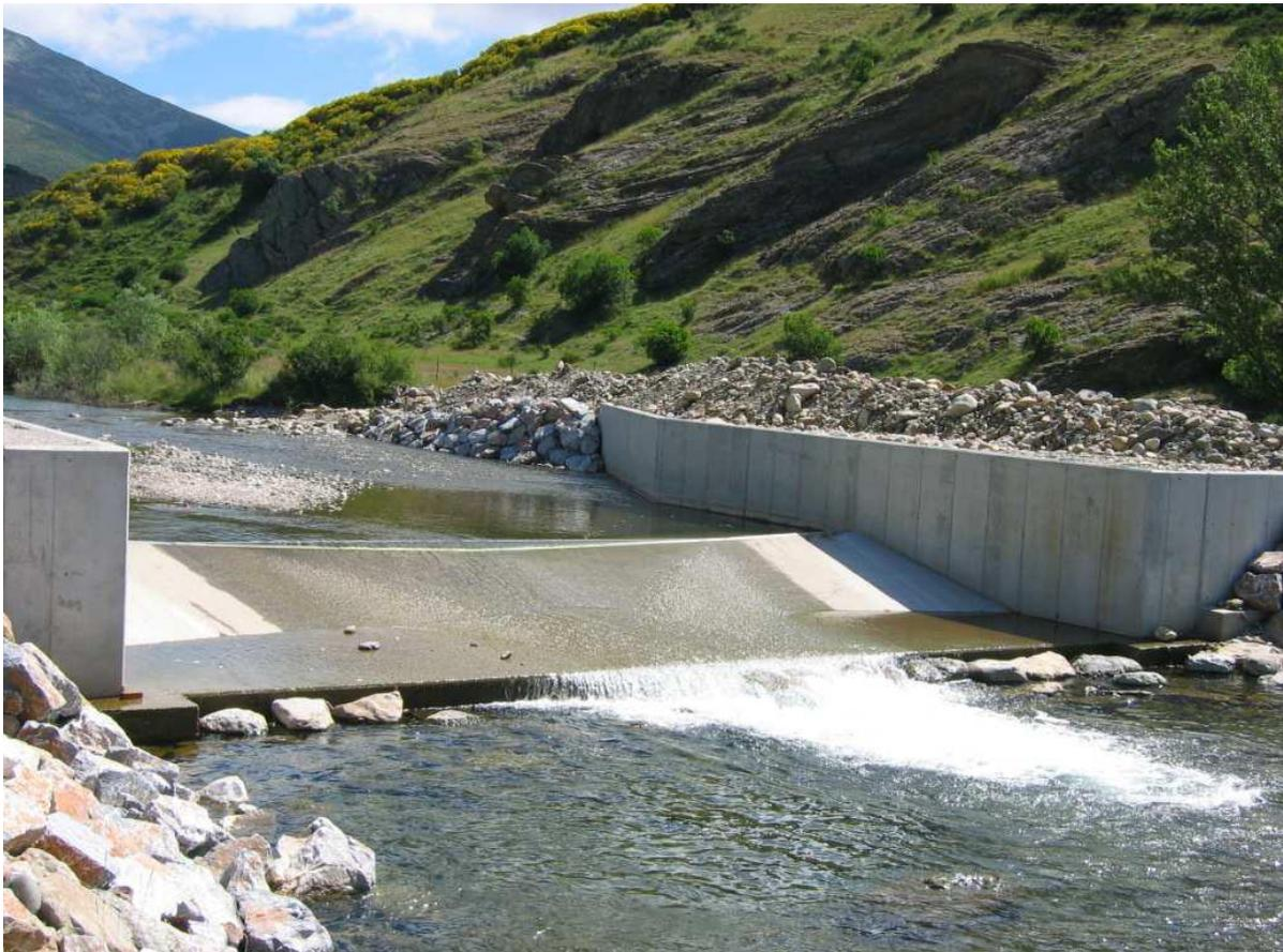
Figura 2.5 Ejemplo de estación de aforos de tipo Vflat donde son patentes muchos de los problemas descritos (Triollo, Palencia). Sanz Ronda et al, (2008)
