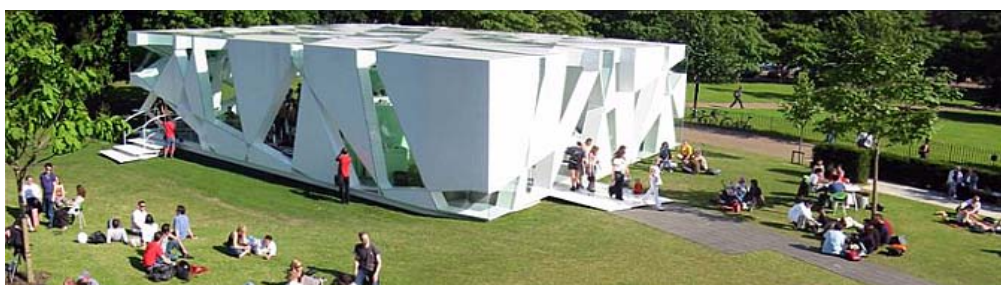
Vista exterior del pabellón terminado. Pabellón Serpentine Gallery . Toyo Ito. Londres. 2002
