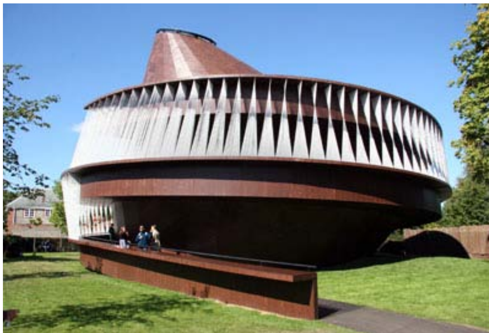
Vista de la fachada de acceso al interior del pabellón Pabellón Serpentine Gallery . Olafur Eliasson y Kjetil Thorsen. Londres. 2007
