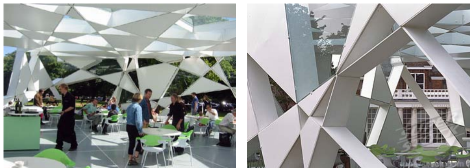
Vistas interiores. Pabellón Serpentine Gallery . Toyo Ito. Londres. 2002
