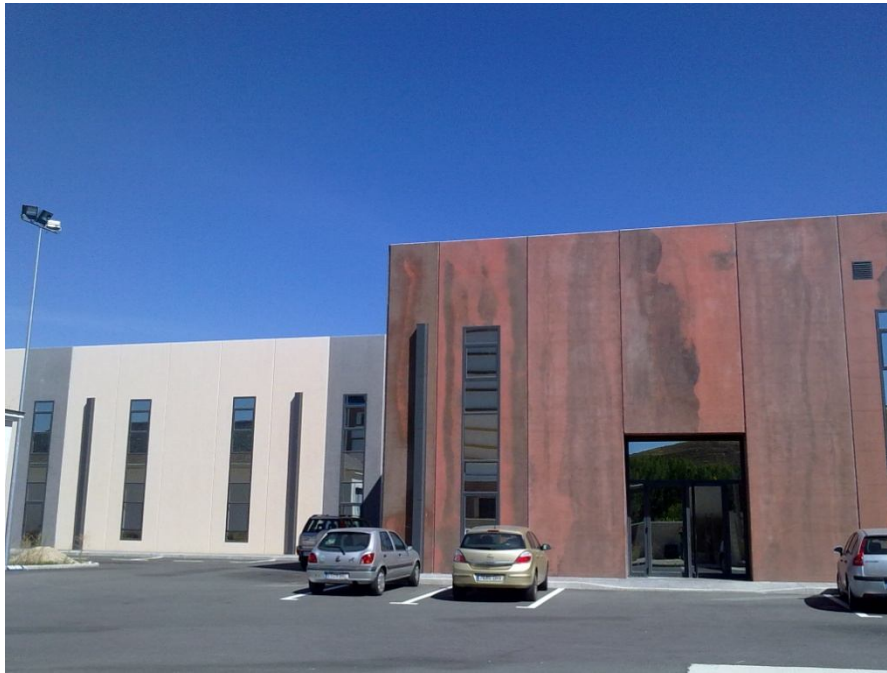
Figura 33. Vista general de la fachada principal del Centro.
