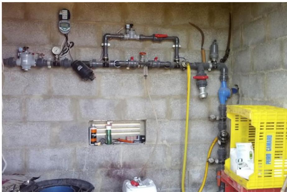
**FOTO 2.16: INSTALACIÓN DE RIEGO POR GOTEO**
