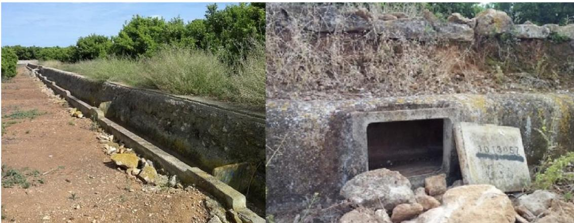
**FOTO 2.15: ACEQUIA DE RIEGO A MANTA POR DESBORDE (IZQUIERDA) Y POR PALETA (DERECHA)**
