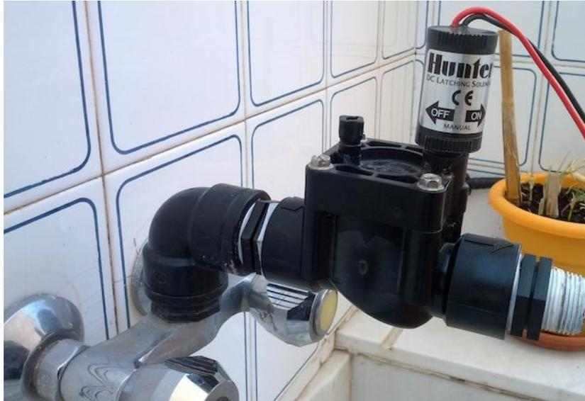
FOTO 7.4: INSTALACIÓN DE LA VÁLVULA DE RIEGO
