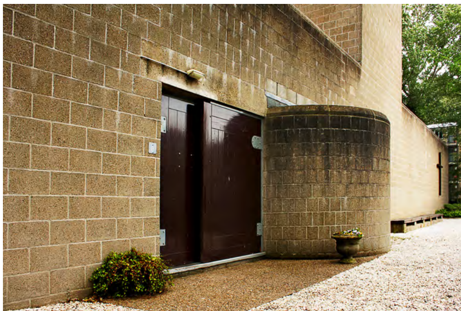
[Imagen 3] Fotografía exterior de la iglesia. Acceso principal (fachada suroeste).
