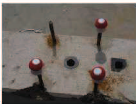
Fotografía 20: Estado de las protecciones tras el impacto.
