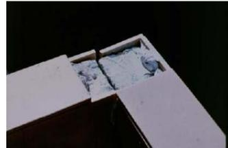
**Síntomas** En primer lugar se produce una falta de ligazón entre la albardilla y el peto de cubierta que se puede traducir en un desprendimiento de las piezas bien hacia el interior de la cubierta o bien hacia la calzada, suponiendo un riesgo para los transeúntes.
