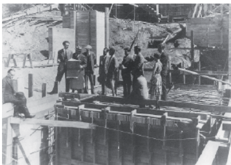
Richard Neutra: Lovell Health House en construcción. Clase y visita de obra a sus discípulos de la Academy of Modern Art, 1929. Fotografía de Willard Morgan. Harris es el quinto personaje por la izquierda.
