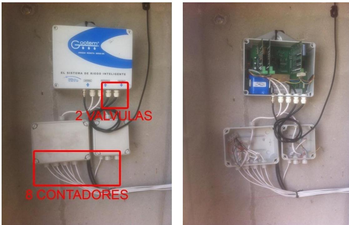
**Ilustración 127: Unidad Remota y cajas de empalmes conectadas**
