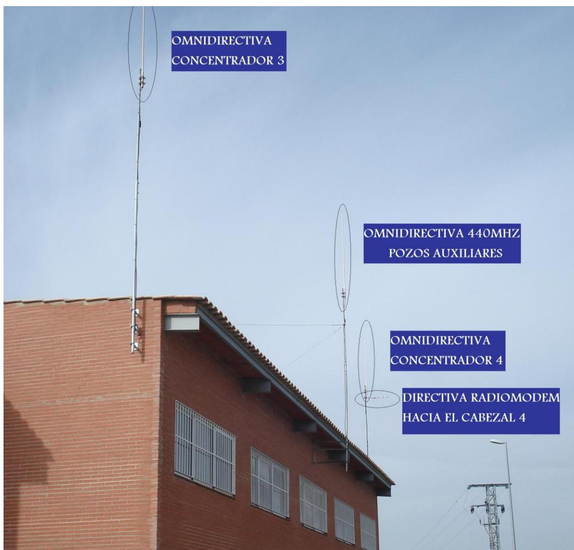
Ilustración 22: Vista de las antenas en Cabezal 3
