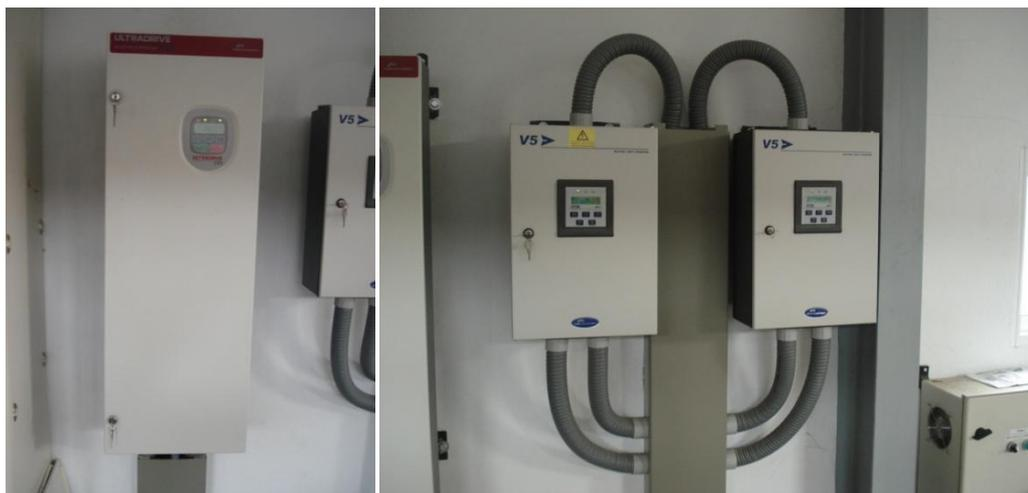
**Ilustración 118: Izda. VARIADOR FREC / Dcha. ARRANCADORES AUXILIARES**
