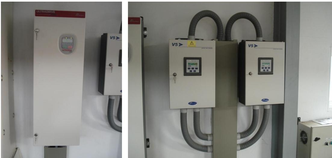
**Ilustración 101: Izda. VARIADOR FRECUENCIA / dcha. ARRANCADORES AUXILIARES CONTROLAN BOMBA DE RED 1 CONTROLAN BOMBAS DE RED 2 Y 3**
