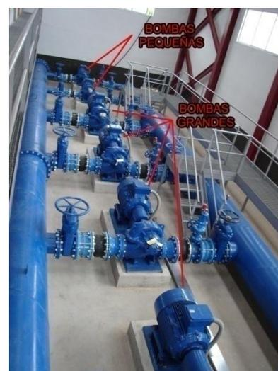
**Ilustración 134: CABEZAL 1, BALSA, COMPUERTAS BALSA, SISTEMA BOMBEO**
