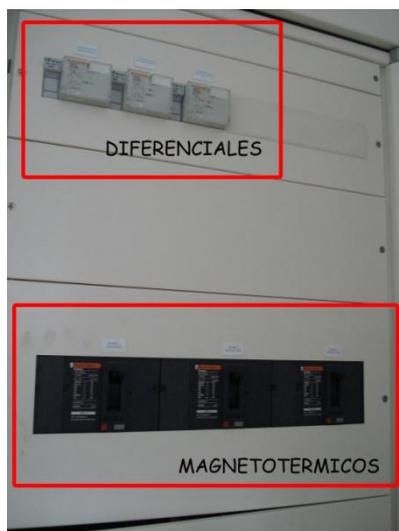
**Ilustración 116: diferenciales y Magnetotérmicos**
