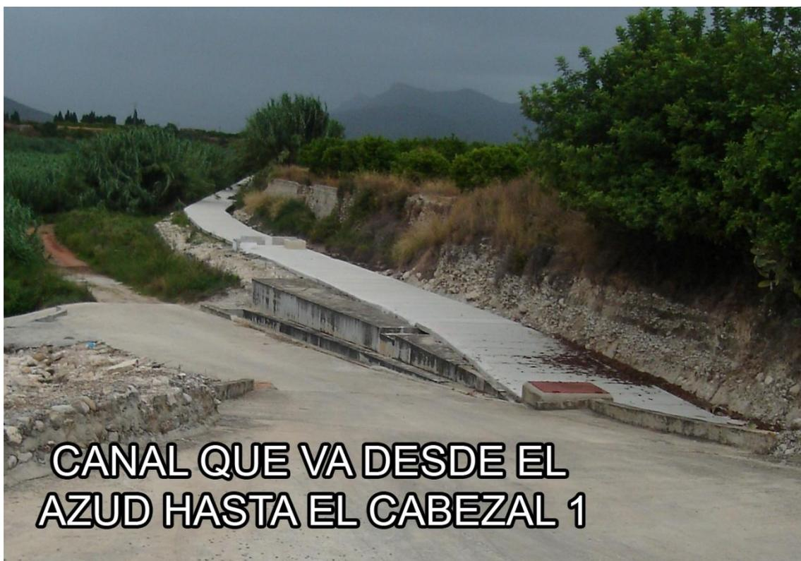
**Ilustración 133: CANAL HIDRÁULICO AZUD - CABEZAL 1**
