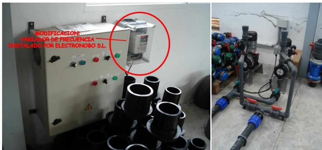
**Ilustración 119: Izda. Cuadro eléctrico para bombas inyectoras fertilizante / Dcha. Bombas inyectoras**
