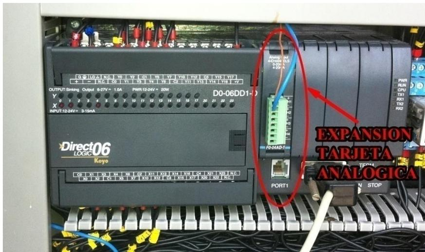
Ilustración 97: Expansión Tarjeta Analógica
