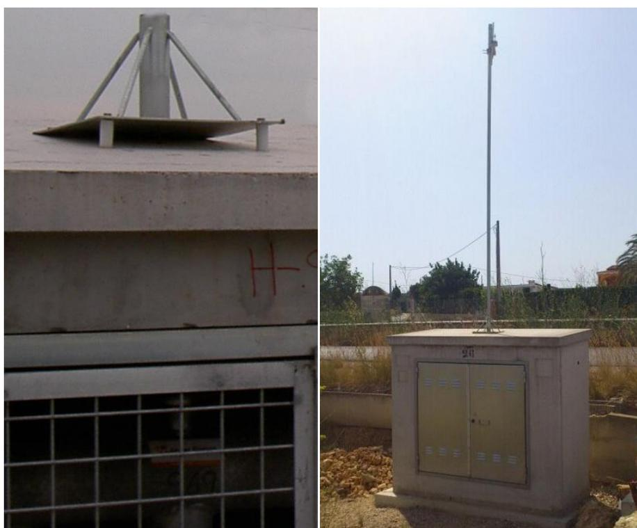
**Ilustración 125: Izda. Base de Antena / Dcha.: Antena Completa**
