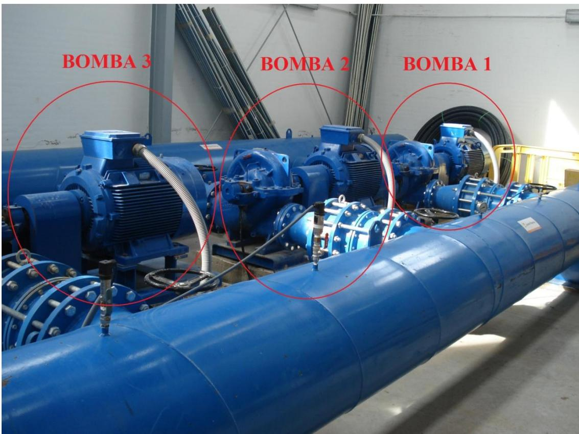
**Ilustración 102: SISTEMA DE BOMBEO DEL CABEZAL 3**
