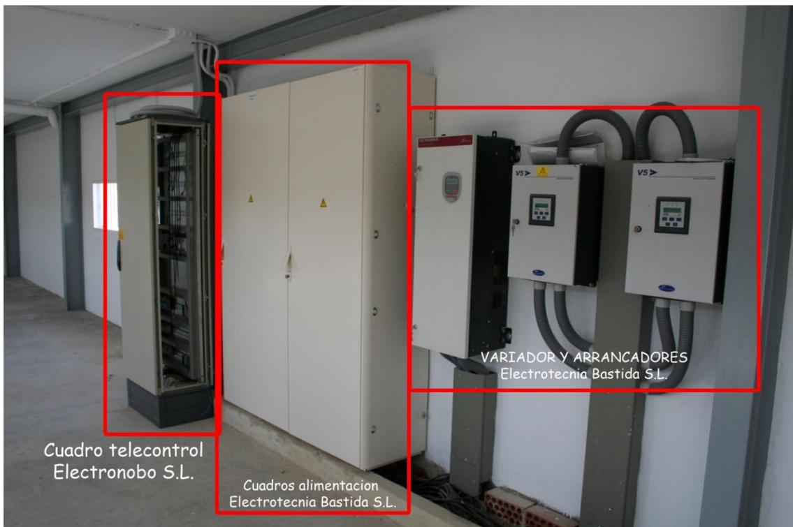
**Ilustración 115: Cuadros eléctricos Cabezal 3**
