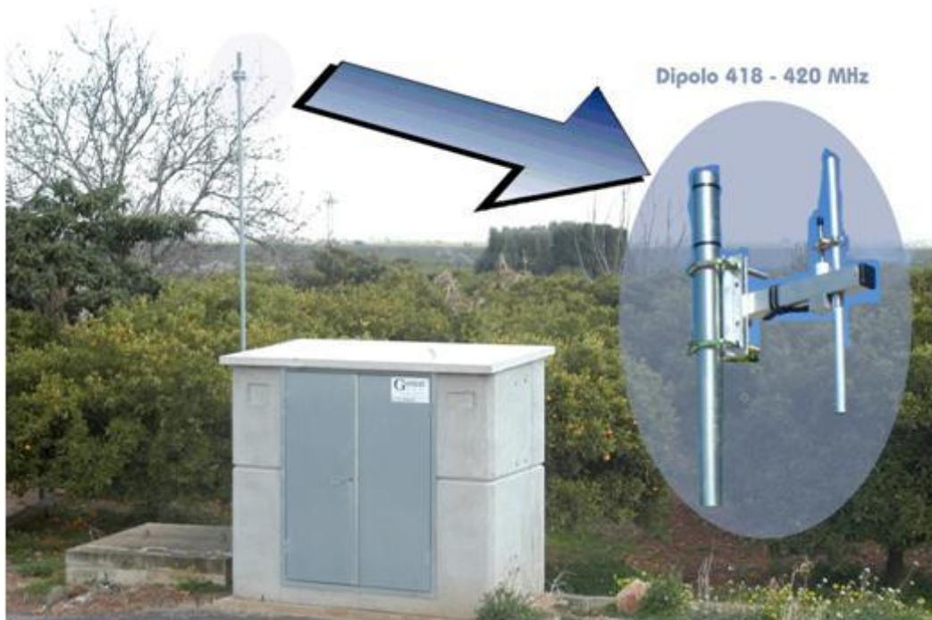
**Ilustración 30: Antena de Unidad remota**
