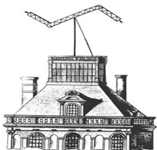
Fig.[24]. Telégrafo Chappe en el Louvre, Francia.
