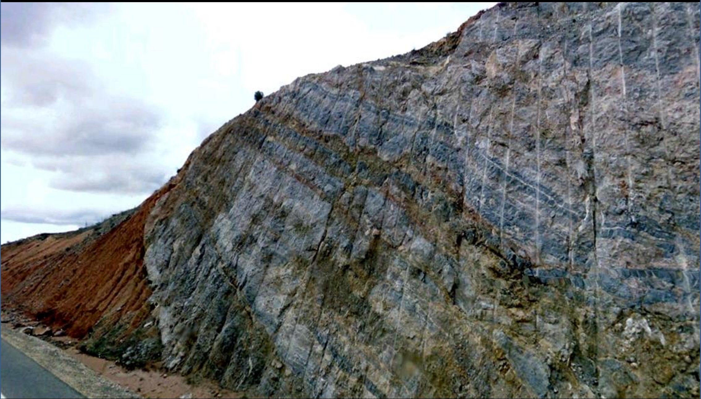
Calizas con niveles margosos verdes, del Jurásico. Y zona de arcillas de descalcificación. S de Pozo-Cañada, Albacete. NW Hoja.
