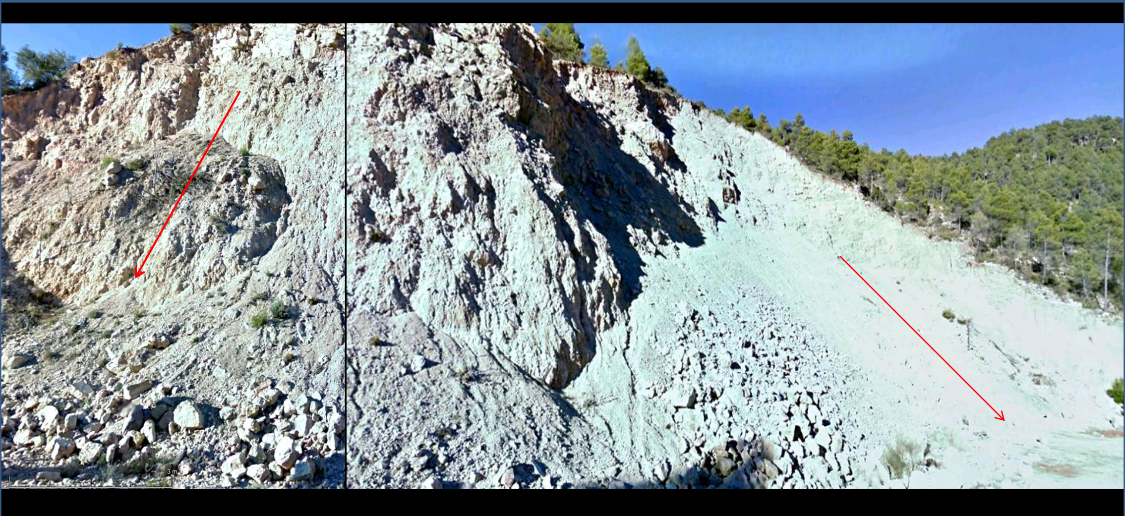
Deslizamientos de ladera en talud en margas del Lías, Jurásico Inf. E de Riomenal. NE Hoja de Alcaraz, Albacete.
