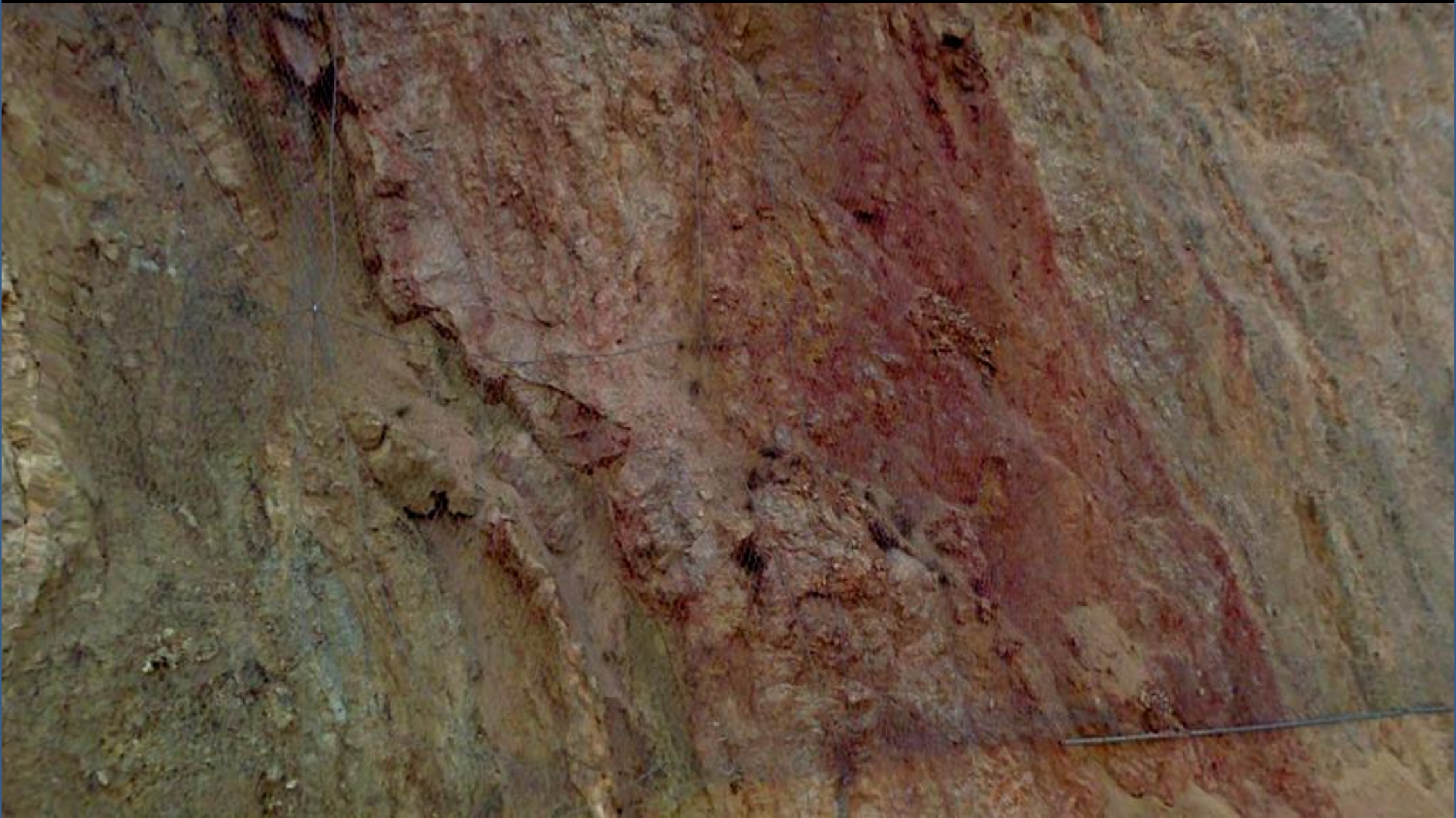
Detalle de anterior: Mallazo sobre probable zona de cabalgamiento Trías Indiferenciado con Lías Inf. SW de Quejigal, Albacete. N Centro Hoja de Siles
