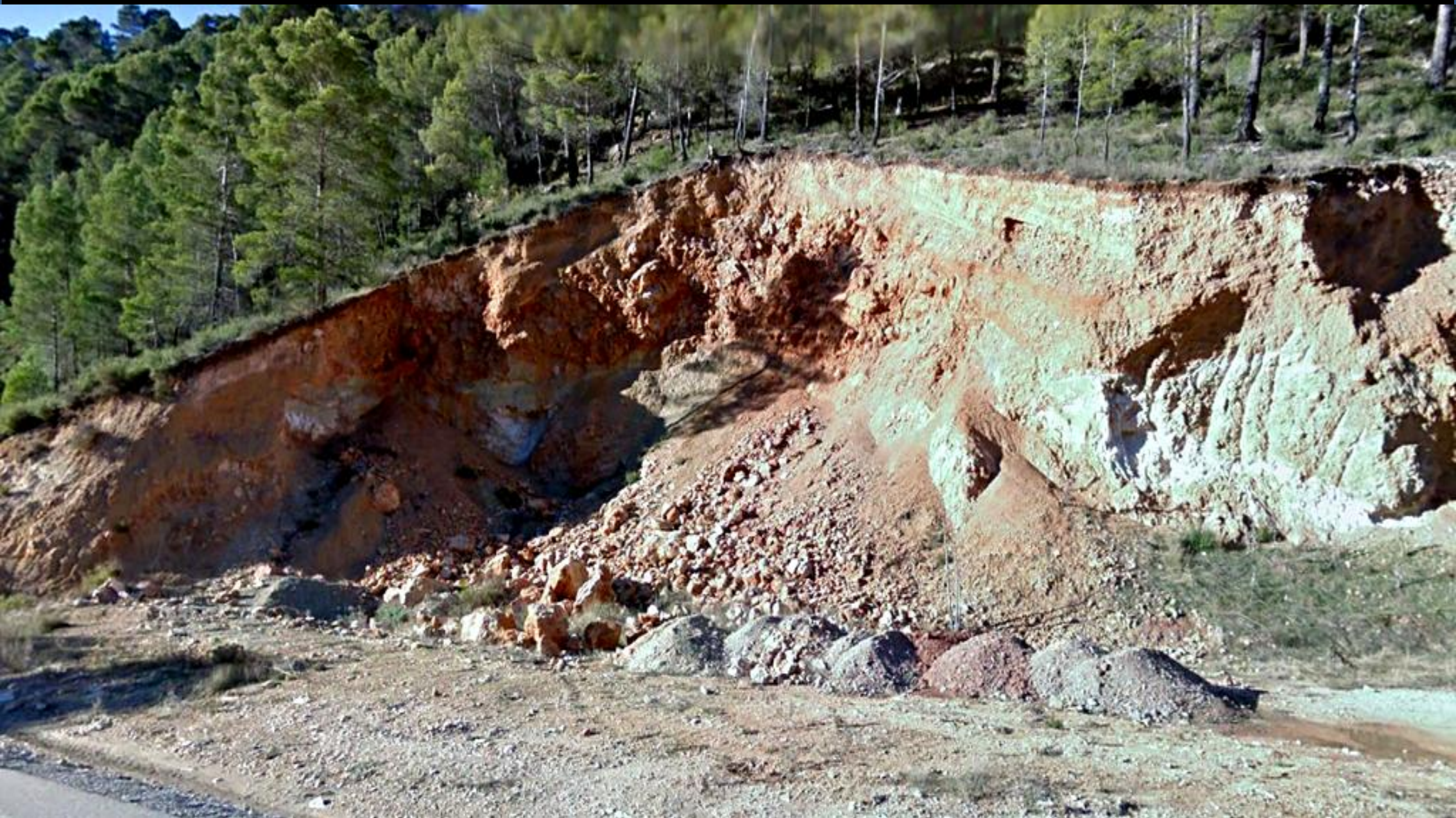
Deslizamiento 'saneado' de depósito de ladera y margas probablemente del Jurásico Inf. N cerro Bañadero. N Centro Hoja de Alcaraz, Albacete.
