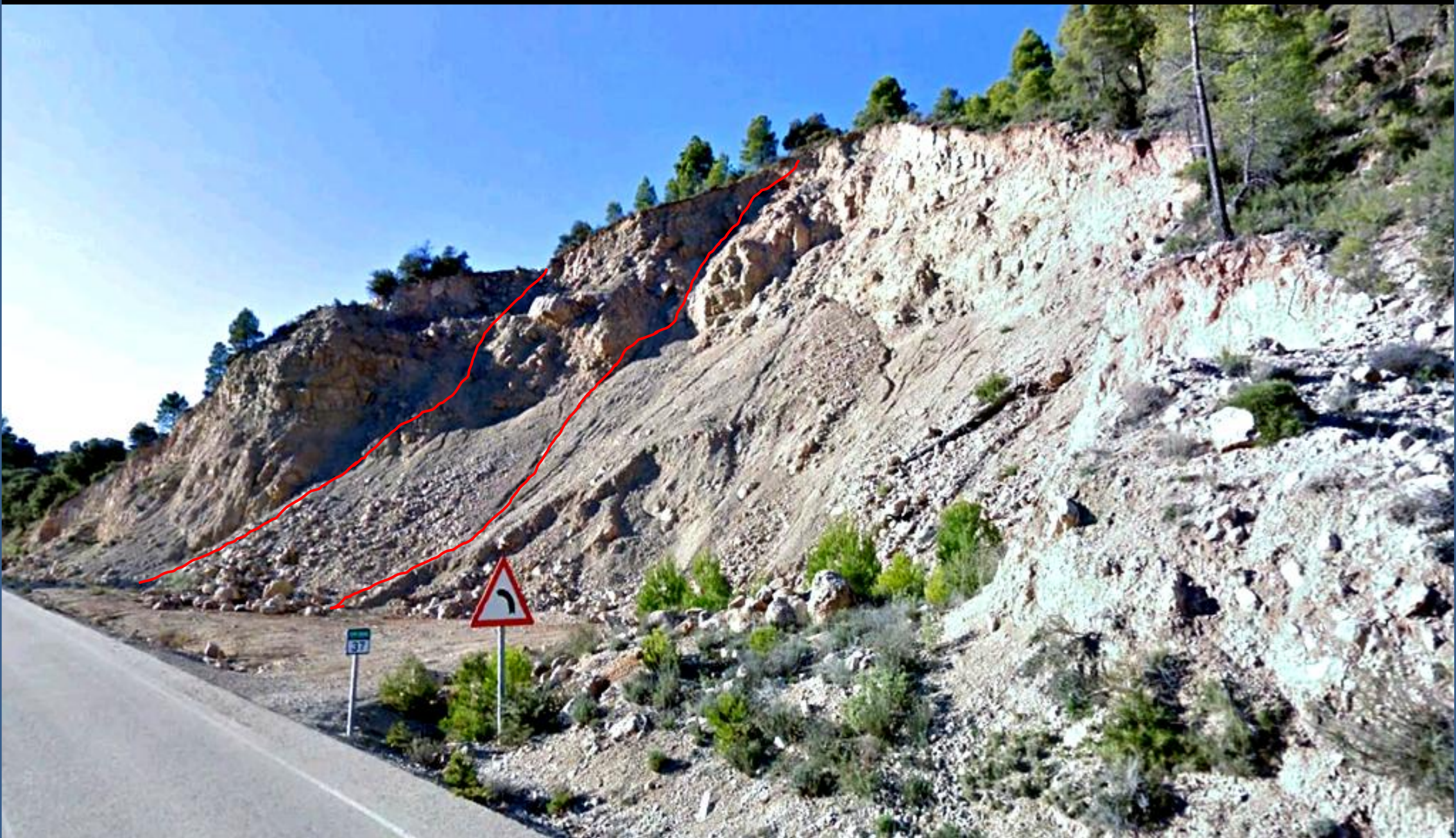
Deslizamiento 'saneado' de calizas y margas, falladas, probablemente del Jurásico Inf. E de Riomencal, Sierra de Alcaraz. N Centro Hoja de Alcaraz, Albacete.
