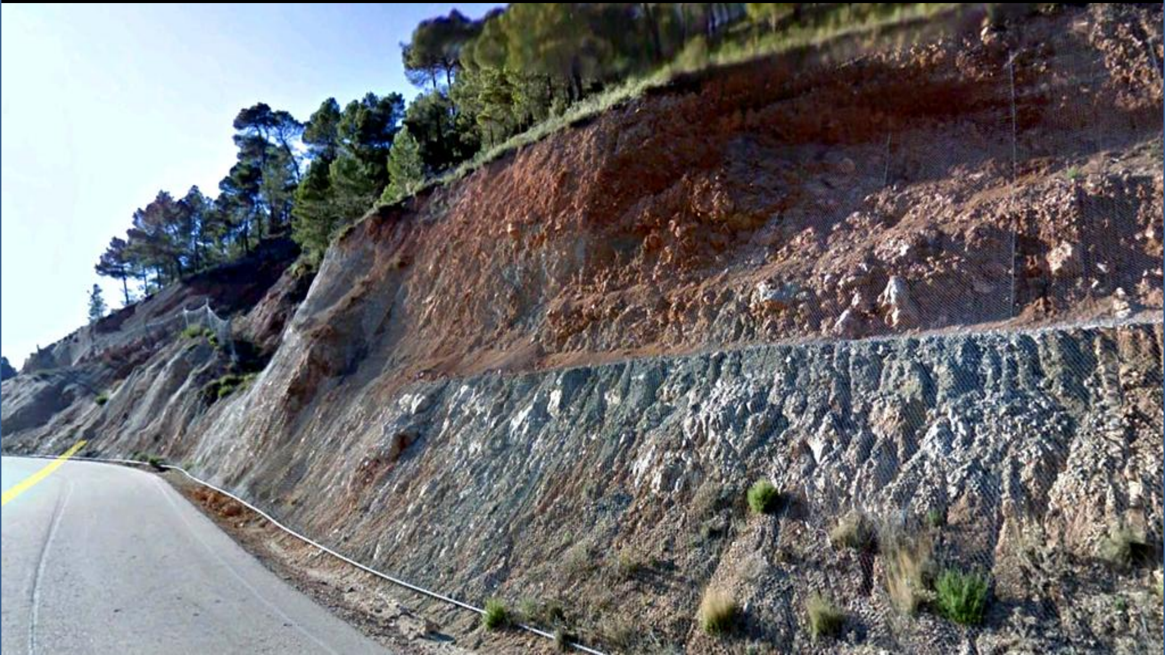
Actuación con mallazo y escalonado en talud de depósito de ladera y margas probablemente del Jurásico Inf. N cerro Bañadero. N Centro Hoja de Alcaraz, Albacete.
