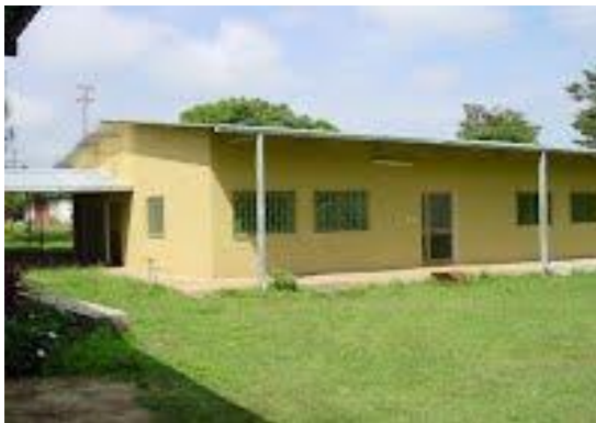
Figura 27: Pabellón del Hospital de Gambo
