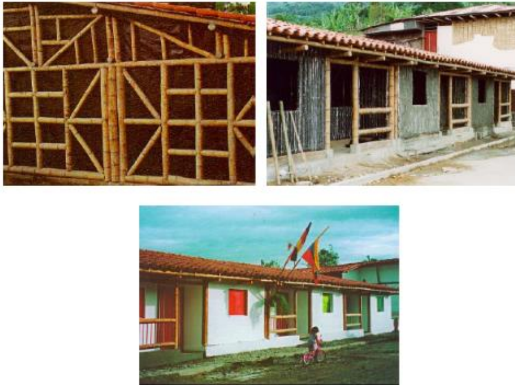
Figura 8. Proceso constructivo de las viviendas promovidas por la GTZ en el eje cafetero después del sismo de 1999.
