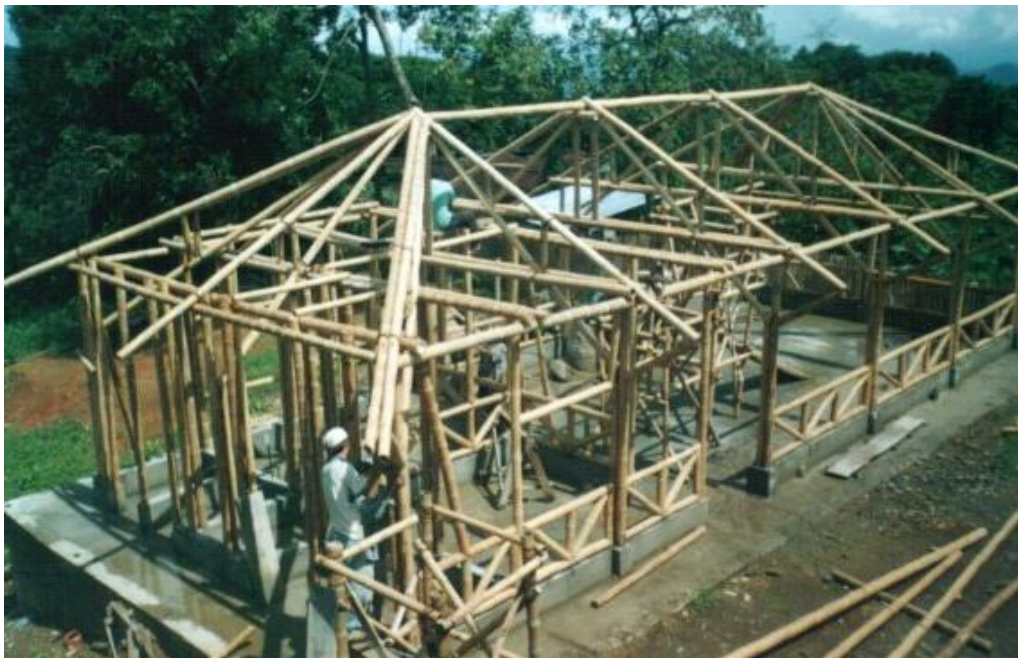
Figura 64. Entramado de muros en guadua sobre cimientos en hormigón.
