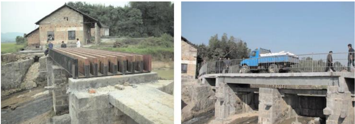
Figura 16. Construcción y prueba de carga de un puente con vigas de bambú laminado en China
