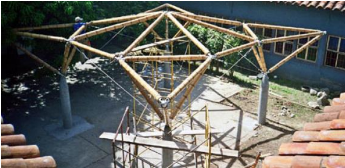
Figura 15. Montaje a escala real de una cúpula geodésica con novedoso sistema de unión en acero.
