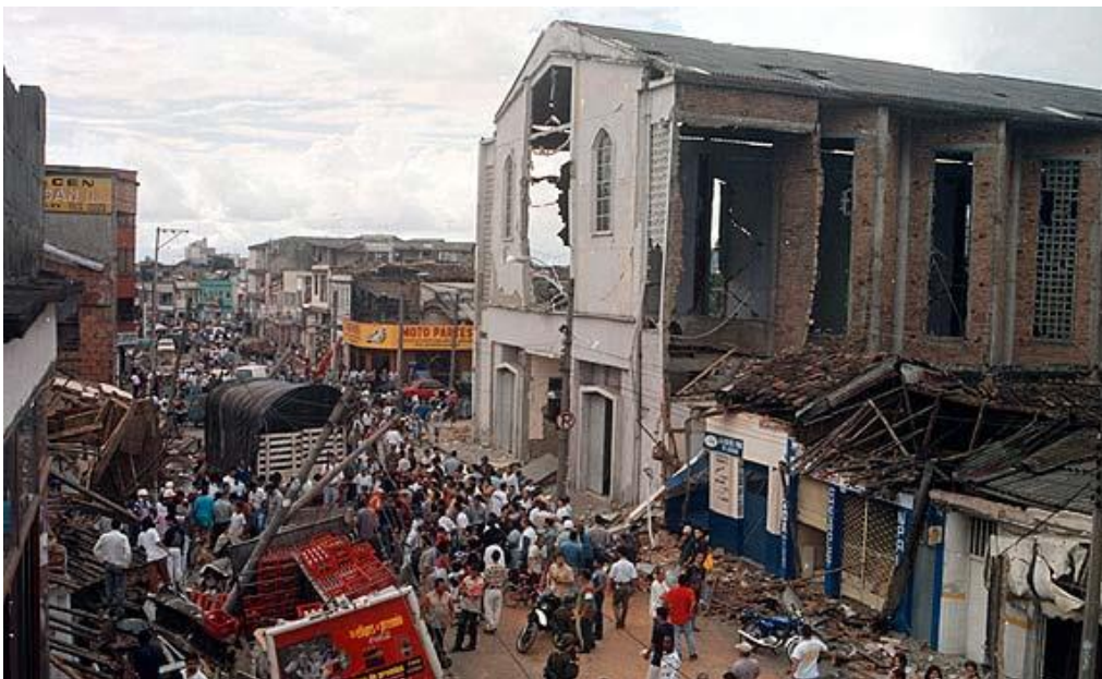
Figura 7. Daños provocados por el sismo de Armenia en 1999.
