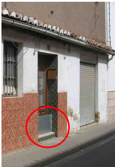
Figura 4-41. Ejemplo de medida de protección temporal de una vivienda tipo en la zona inundable de la Rambla del Poyo (EIXIMENIS, 2008).
