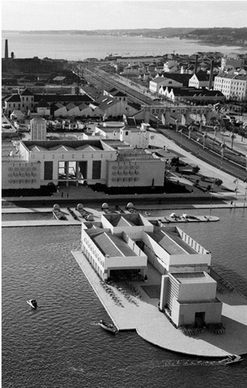
Figura 29. Fotografia lado oeste do Pavilhão dos Portugueses no Mundo
