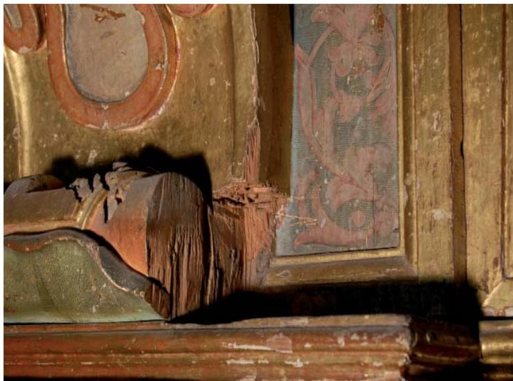
Figura 46 (izquierda).- Ángel. Amputación de la mano y parte del pie. Figura 47 (derecha).- Ménsula. Amputación de la voluta de la parte inferior.
