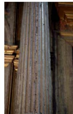
Figura 8 (izquierda).- Galerías de xilófagos. *Anobium Punctatum*. Figura 9 (centro-izquierda).- Pérdidas de volumen debido a insectos xilófagos. Figura 10 (centro-derecha).- Alteración biológica. Vista general. Figura 11 (derecha).- Alteración biológica. Detalle.
