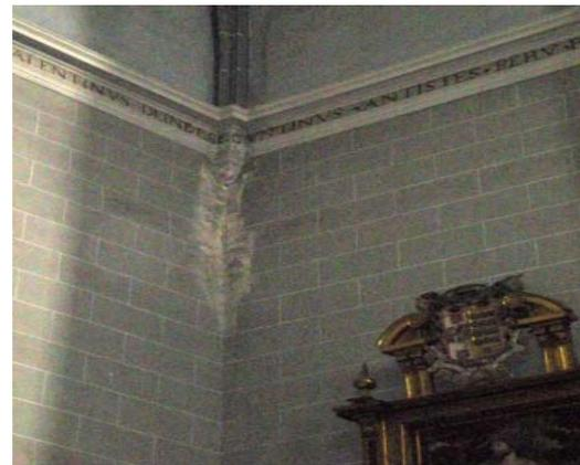
Figura 1 (izquierda) y 2 (derecha).- Goteras en las bóvedas y muros (respectivamente) de la Iglesia de la Magdalena. Valladolid.
