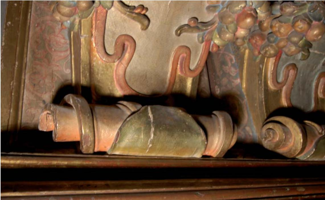
Figura 57.- Grieta a lo largo de un campo de tensión y desprendimiento del estrato pictórico. Ménsula.
