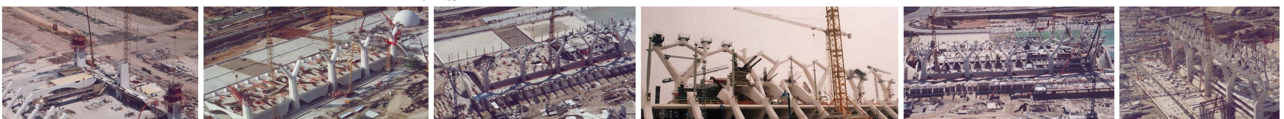
Seguimiento fotográfico de la ejecución de los pilares.
