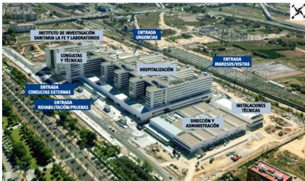
Ilustración 3. Estructura Hospital Universitario y Politécnico La Fe
