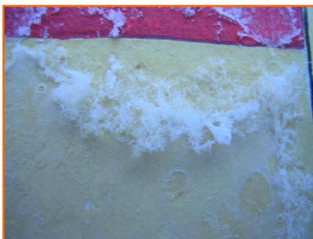
FIGURA 6. DETALLE EFLORESCENCIA SALINA
