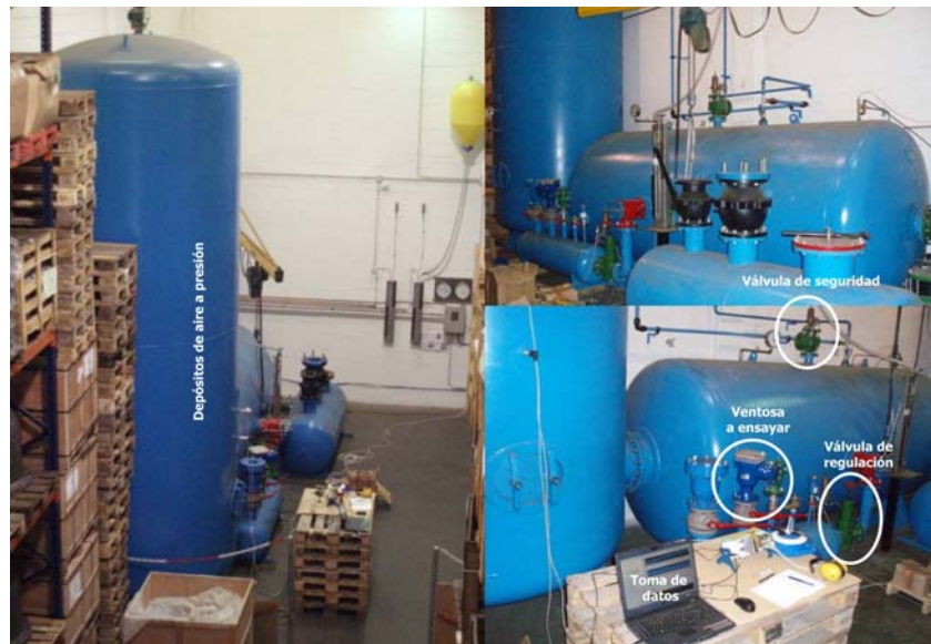
Figura 3.8.- Instalación de ensayo de ventosas.
