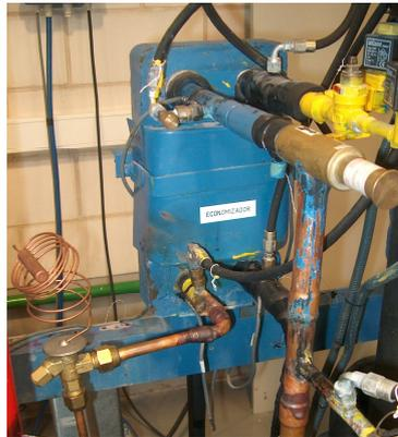
Figura 2. 12. Subcooler de placas y válvula de expansión del subcooler
