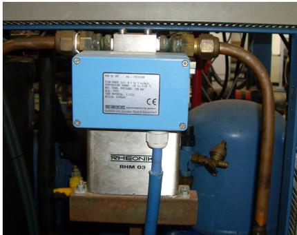
Figura 2. 18. Caudalímetro Coriolis
