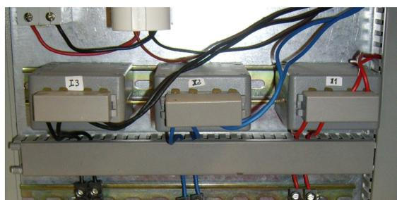
Figura 2. 21. Transformadores de intensidad para medida del consumo
