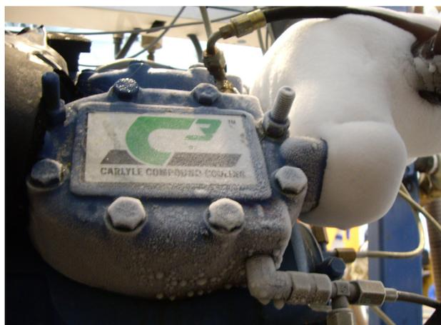
Figura 2. 32. Detalle de congelación de los cilindros de la etapa de compresión de baja durante el funcionamiento anómalo con propileno-glicol/agua al 50% en volumen
