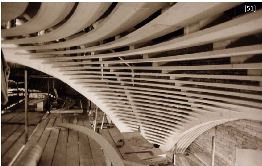
[50 y 51] Imágenes de la construcción de las bóvedas. (CERVELLATI: 2009)
