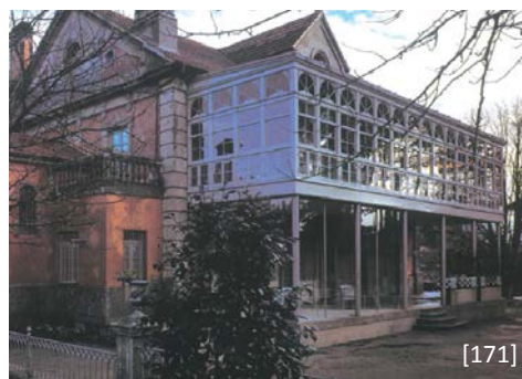
[170] La Casa de Europa. Aspecto de la galería acristalada antes de la restauración. (PORTELA: R&R, nº 72, 2003, p. 27)
