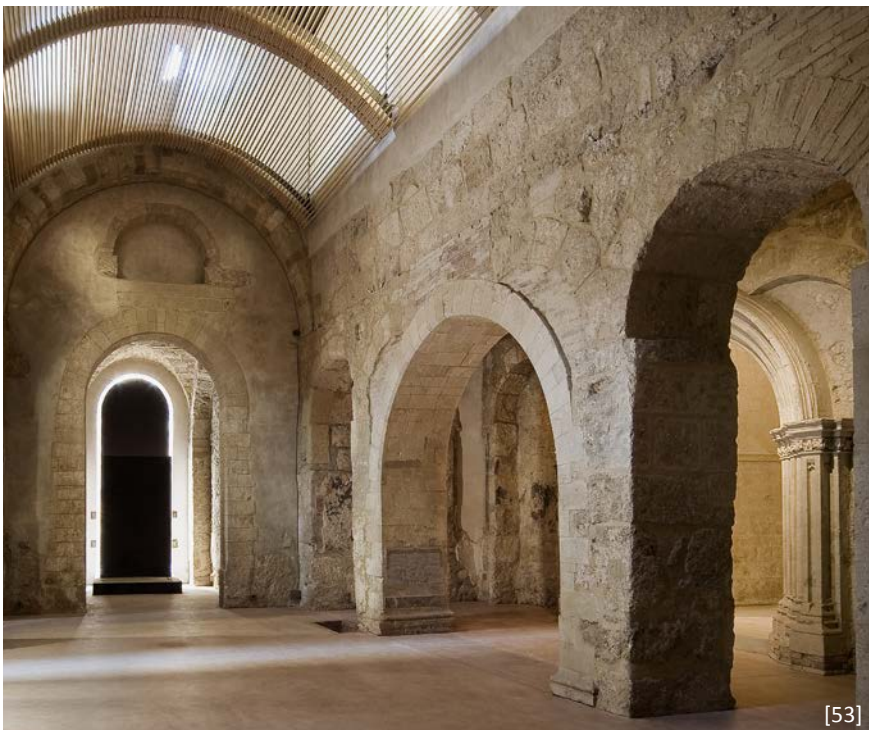
[53] Vista interior en la que se aprecian las diferentes fases del monumento. (FIDONE: R&R , nº 116-117, 2012)
