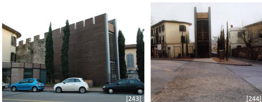
[243] Corridore de Prato. Vista lateral del encuentro entre la muralla original y el nuevo tramo. (Imagen del autor.)
