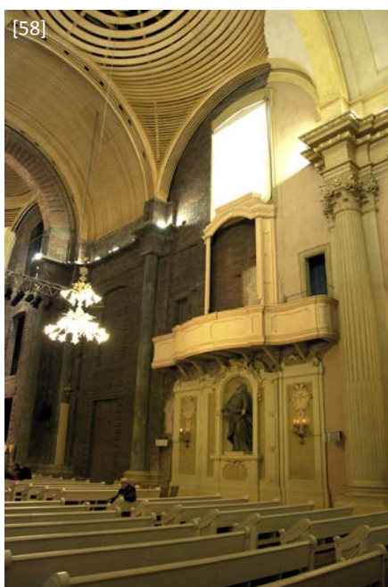
[57 y 58] Vistas de la nave en las que se aprecia el empleo de nerofumo . (Imágenes del autor)
