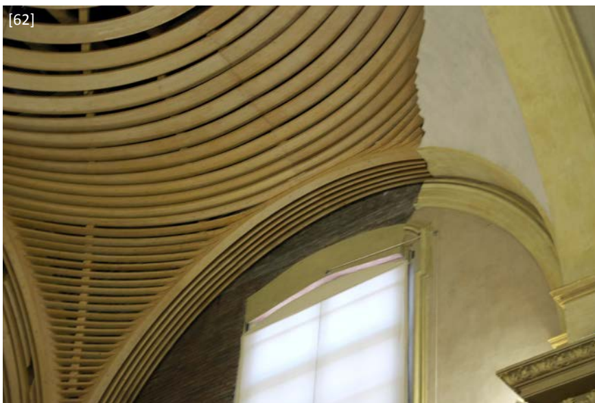
[62] Detalle de las láminas de madera que componen la bóveda y sus diferentes curvaturas. (Imagen del autor)
