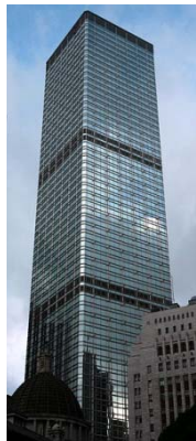
Imagen 4. Cheung Kong Centre, Hong Kong
