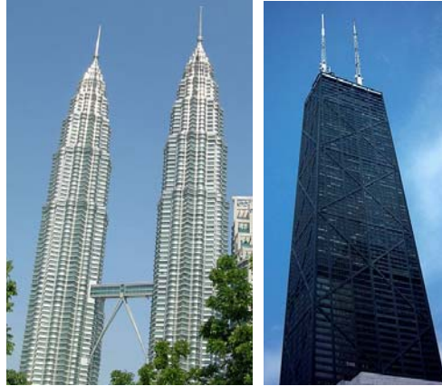
Imagen 5. Torres Petronas (Kuala Lumpur), John Hancock Center (Chicago)
