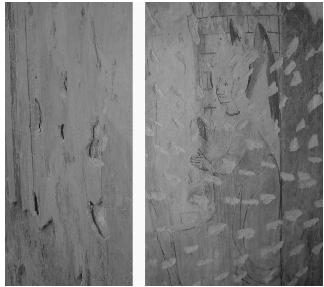
Figura 6. S'observen la descohesió dels estrats dels morters i les picades fetes per a que agarre el morter que cobria i ocultava les pintures
