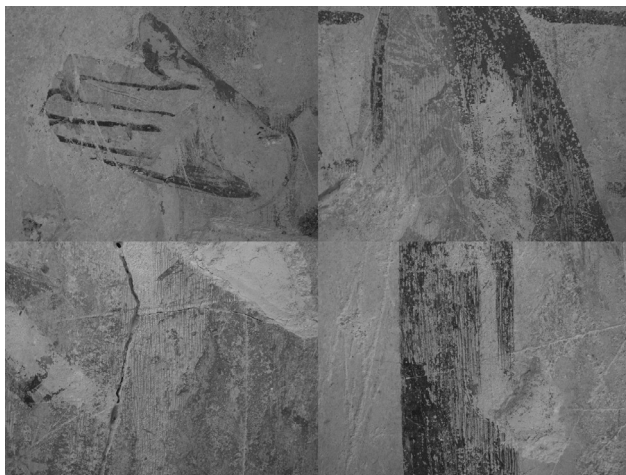
Figura 10. La imatge mostra el moment d'aplicació del hidrofugant
