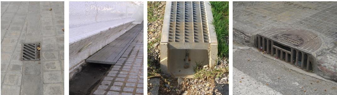
*Imagen 8. La fundición es el material más empleado para estos elementos, no obstante encontramos también rejas de hormigón, de piedra natural o realizadas con pletinas de acero galvanizado. Las condiciones de utilización son las que determinarán las posibilidades de uso de los distintos materiales.*
