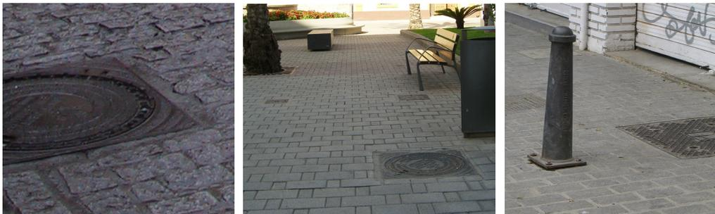
Imagen 9. Las tapas deben quedar enrasadas en el pavimento, tener una superficie antideslizante e indicar el servicio al que corresponden.
