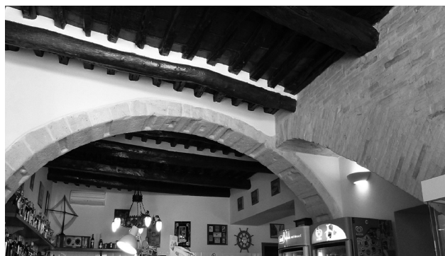
Figura 8. La vivienda urbana de Carloforte. Encuentro entre el arco de muro central y la bóveda de la escalera (2010)
