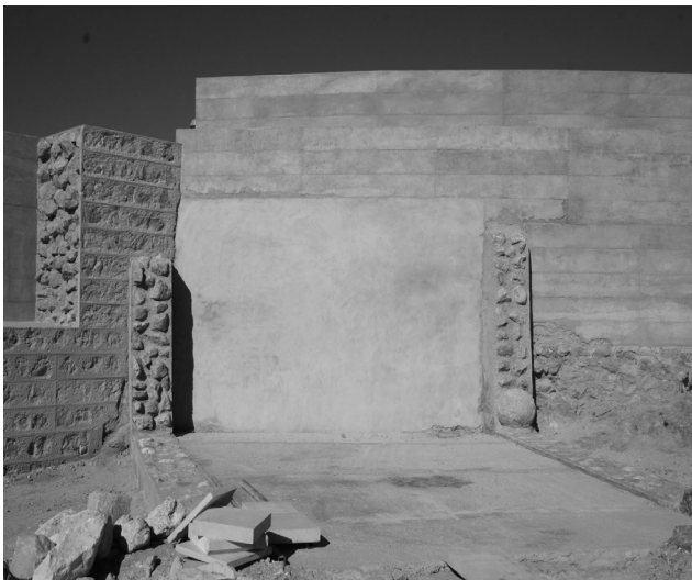
Figura 25. Lienzo interior del muro Norte. Huella de la antigua ermita
