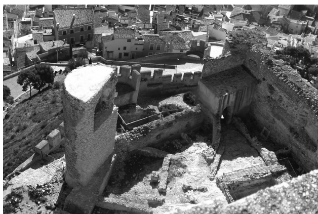
Figura 17. Vista anterior a la intervención desde la torre del Homenaje
