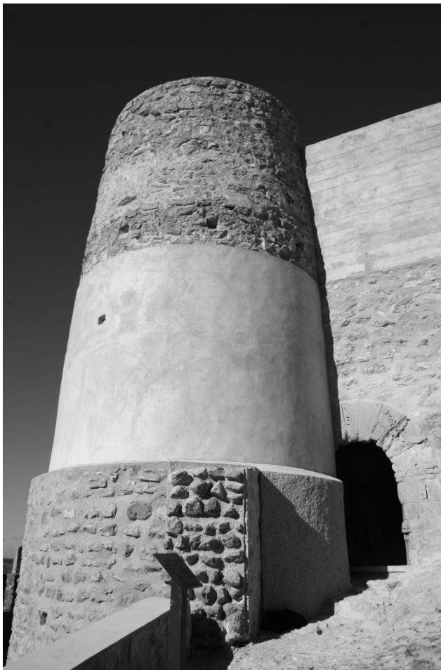
Figura 19. Torre Sur y acceso
