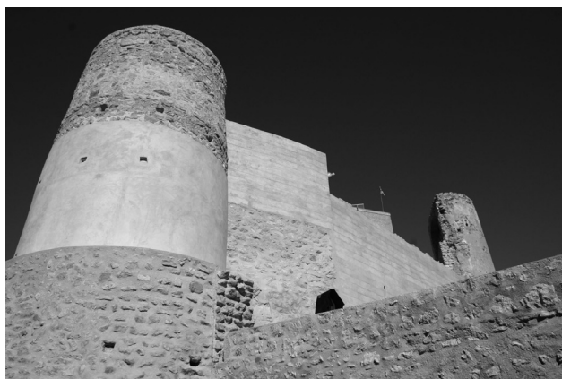
Figura 18. Exterior del muro Sur y la torre Sur tras la intervención
