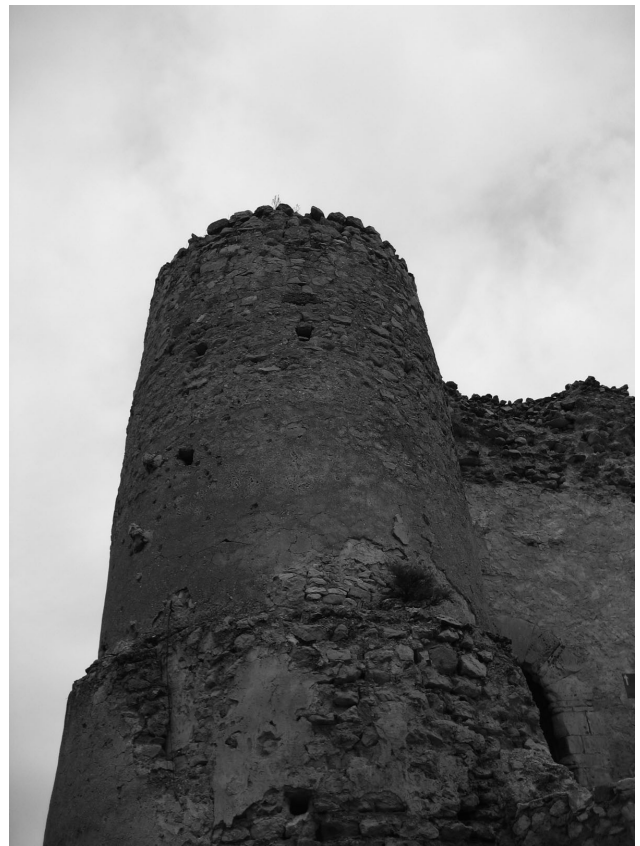
Figura 7. Torre Sur de la muralla interna antes de la intervención
