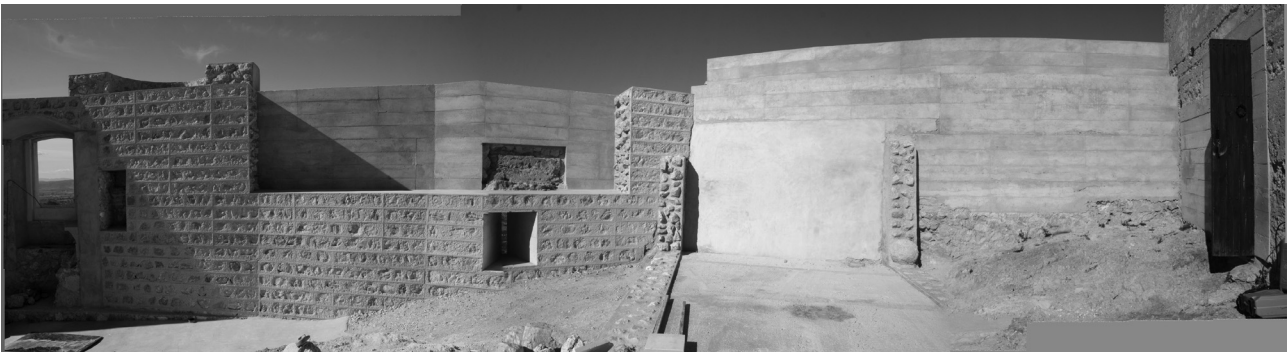
Figura 26. Comparativa del estado anterior y posterior a la intervención del lienzo interior de los muros Oeste y Norte
