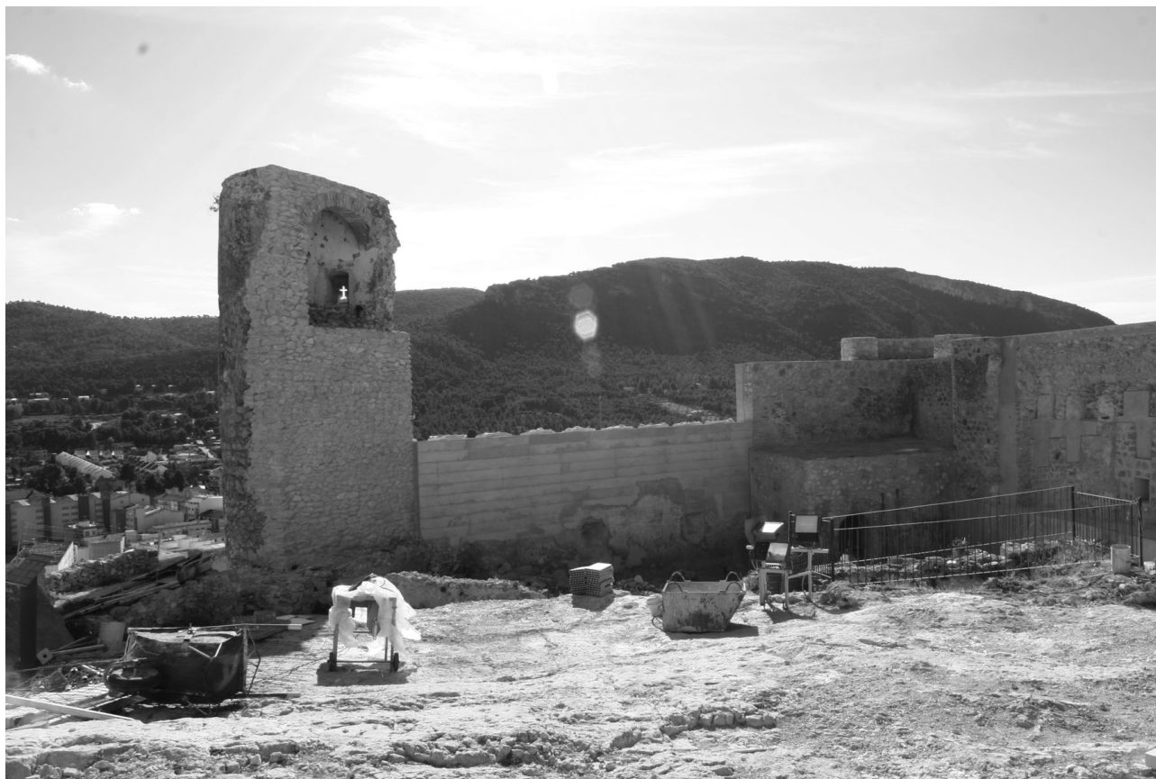
Figura 2. Vista del interior del recinto del Castillo en fase de intervención
