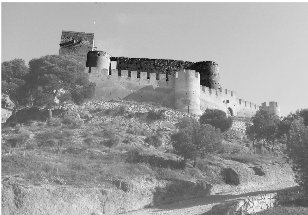
Figura 23. Comparativa del estado antes y después de la intervención de la cara Oeste del Castillo de Biar
