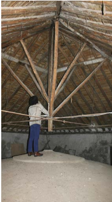
Medición de las piezas de la armadura de la cubierta. Iglesia de San Gabriel de Loja. Granada
