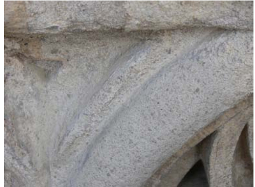
Resultado final tras la restauración. Capilla Real de Granada. FOTOGRAFÍAS: TARMA.
