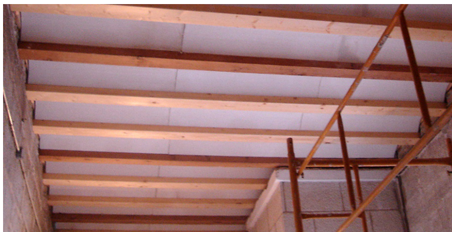
Uso del material ensayado. Catedral de Jaén.
