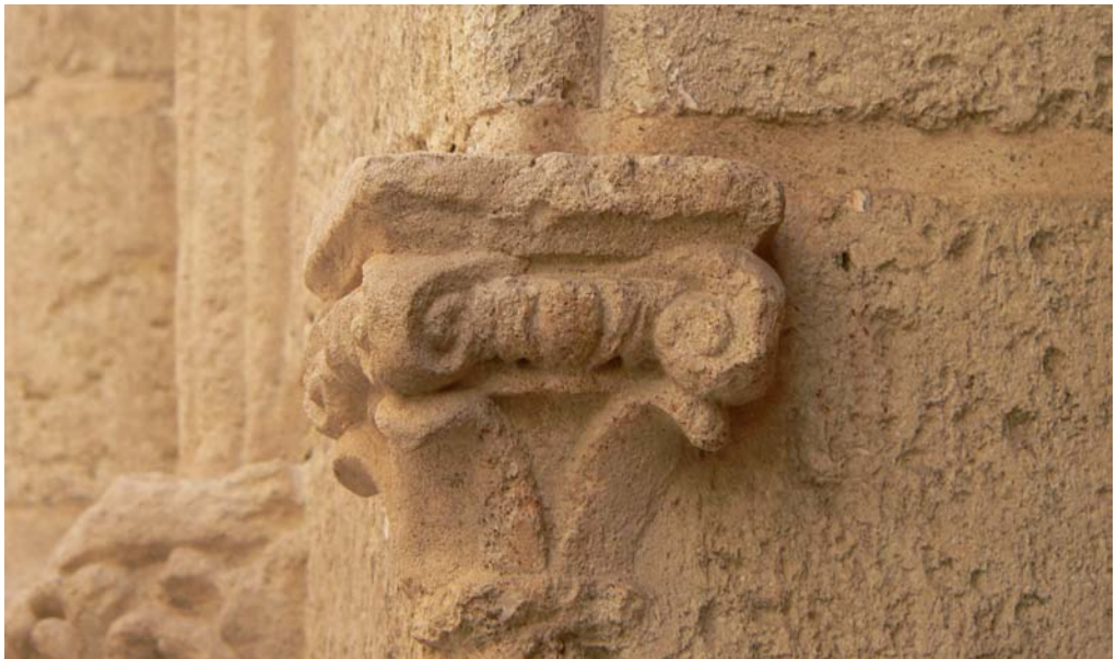
Capitel realizado con mortero aditivado y molde de silicona. Casa de Don Hernando de Zafra, Granada. FOTOGRAFÍA: TARMA
