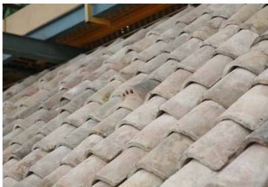
Teja de ventilación colocada. Sala de los Reyes en la Alhambra de Granada
