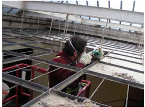
Retirada de la masilla de pescado endurecida de la vidriera suspendida
