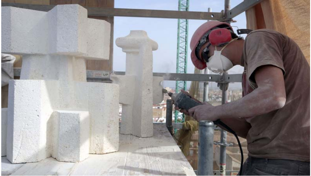
Talla de piezas de piedra en obra. Hospital Real, Granada.
