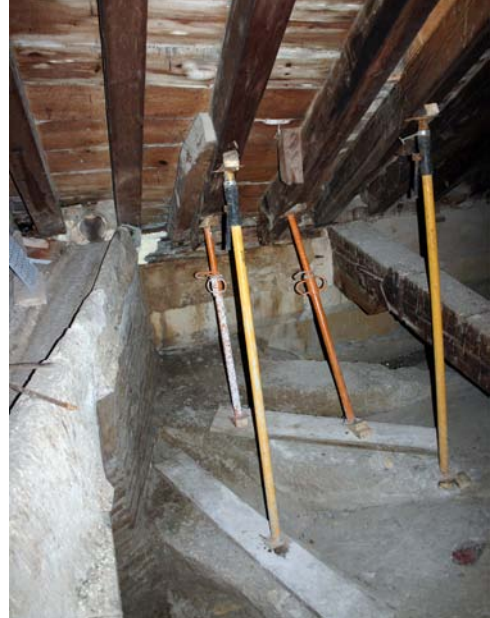
Apuntalamiento provisional bajo cubierta. Catedral de Granada.
