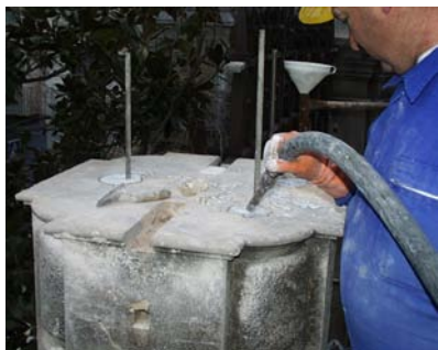
Vibrado del mortero de recibido de los vástagos. Verja de la Lonja. Catedral de Jaén.
