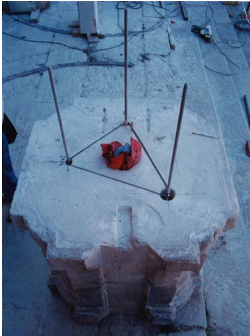
Vástagos de acero inoxidable para el armado de las pilastras. Atado mediante estribo oculto. Verja de la Lonja. Catedral de Jaén
