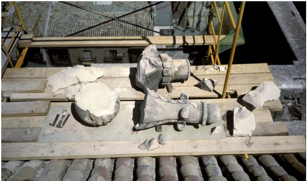
Pináculo desmontado sobre la plataforma de un andamio. Catedral de Jaén.
