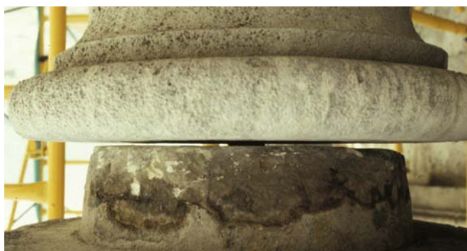
Detalle de la junta entre el pináculo y su base limpia, sin morteros ni cuñas.
