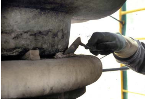
Relleno de la junta con mortero de cal.
