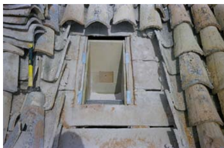
Hueco realizado en la tablazón y colocación de la caja nido. Cubierta de la Catedral de Jaén.
