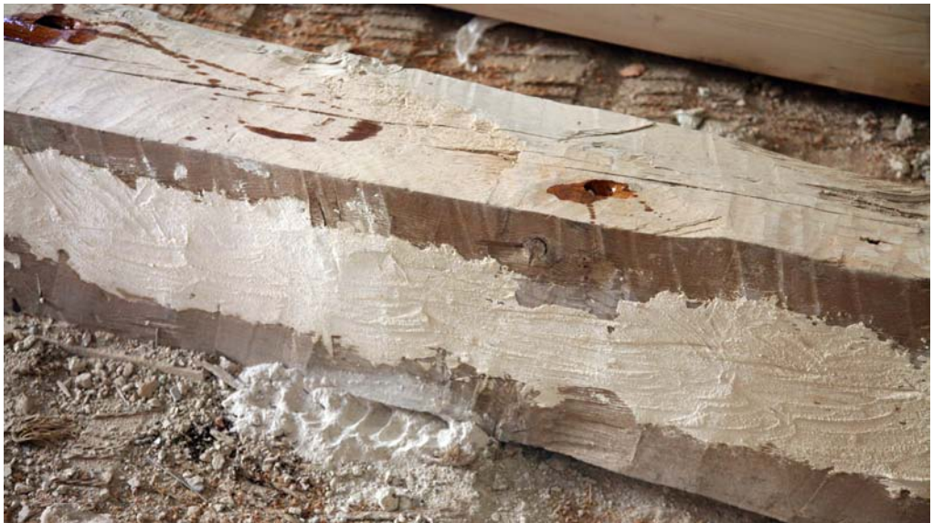
Cosido con varilla de fibra de vidrio y resina epoxi y detalle de viga intervenida. En todos los casos, se puede ver el sellado lateral de las fendas con mortero de yeso. Palacio de las Columnas, Granada.
