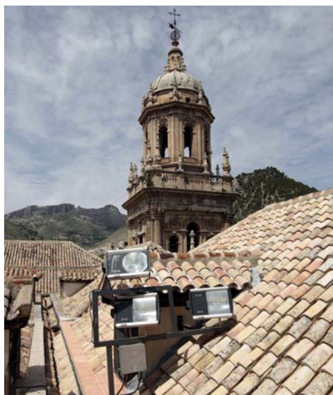
Instalación de luminarias. Catedral de Jaén.
