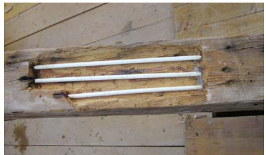
Par saneado con barras de fibra de vidrio a la espera del vertido de mortero epoxi. Catedral de Jaén.
