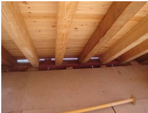
Durmiente con encamisado metálico. Catedral de Jaén
