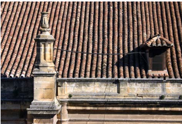
Tendido de cables. Catedral de Granada.
