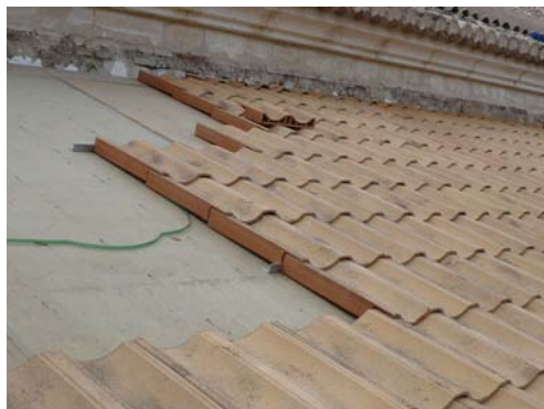
Colocación de cobijas. Cubierta C/ Campanas. Catedral de Jaén
