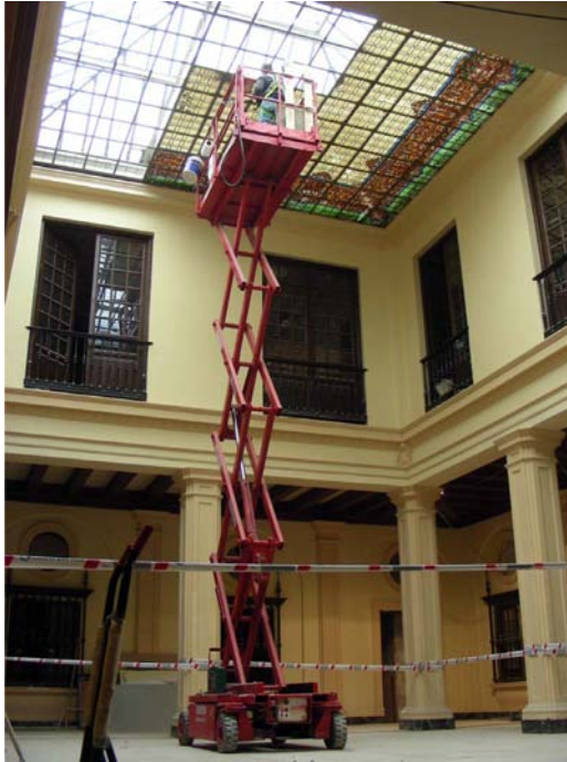
Retirada de los paneles de la vidriera del Palacio de Bibataubín usando una plataforma elevadora hidráulica como medio auxiliar.
