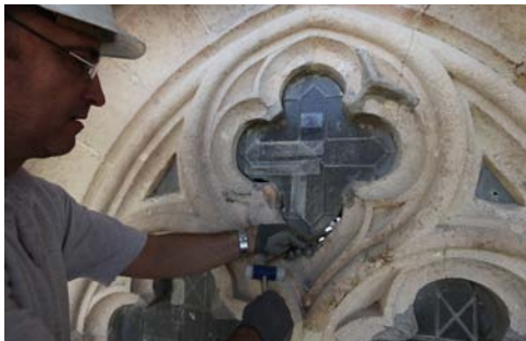
Protección de las zonas con la matriz de plomo debilitada. Vidrieras del Címborio del Hospital Real
