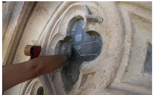
Retirada de morteros de recibido de la vidriera
