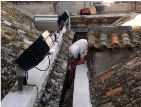
Revisión de elementos de evacuación. Catedral de Jaén.
