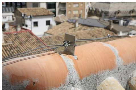
Detalle de la línea de vida colocada en la Catedral de Jaén.
