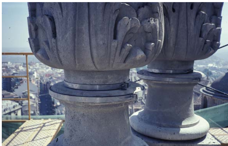
Anillos realizados con pletina de acero inoxidable y banda de neopreno: superior para el confinamiento de la junta, inferior para el zunchado de la base del pináculo. Catedral de Jaén.
