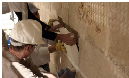
Colocación de un sillarejo
