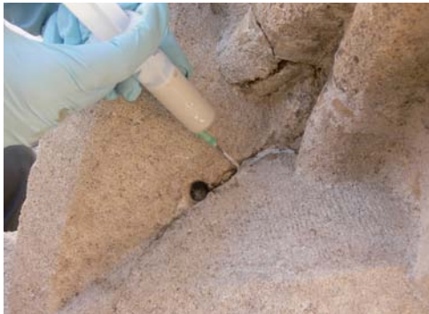
Inyección de mortero PLM en una fisura.
