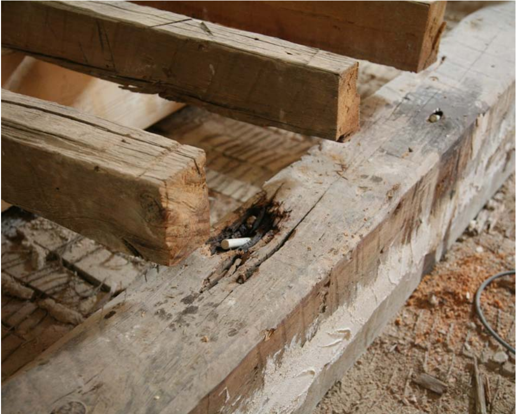
Cosido de viga de forjado con varillas de fibra de vidrio. Palacio de las Columnas, Granada.
