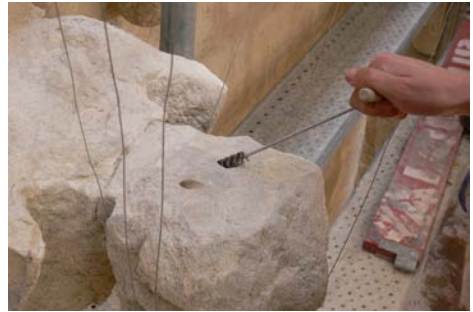
Limpieza de los taladros
