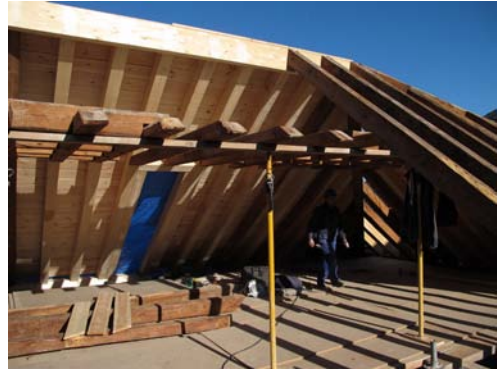
Sustitución de la hilera y algunos pares. Catedral de Jaén.
