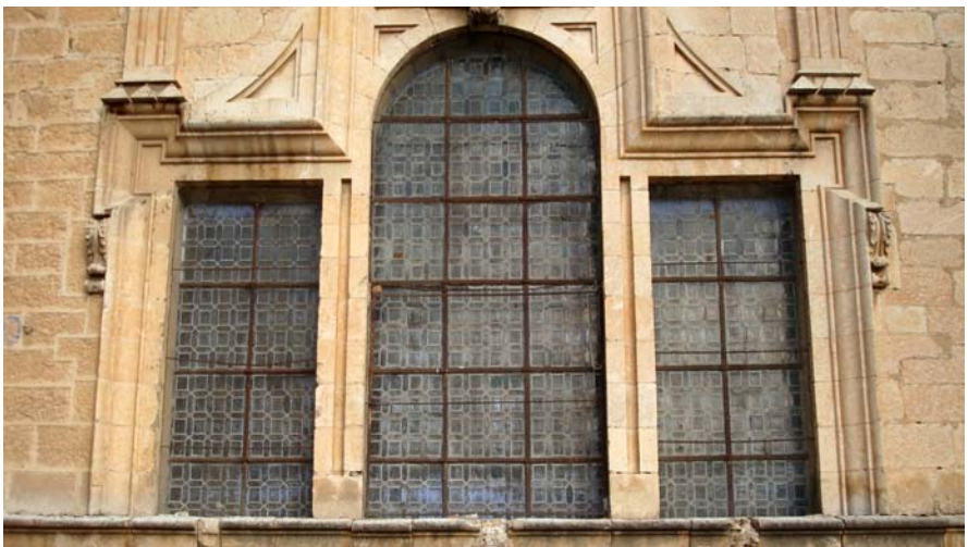
Panel de vidriera con dos órdenes de estructura: una principal de hierro y la matriz de plomo de los paneles vítreos, Catedral de Jaén.
