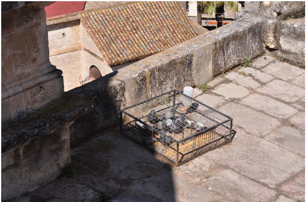
Instalación de jaulas en la cubierta de la Catedral de Granada.
