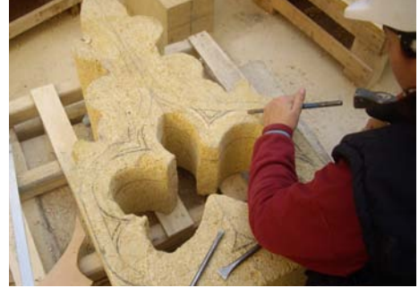
Colocación de la pieza. Capilla Real de Granada
