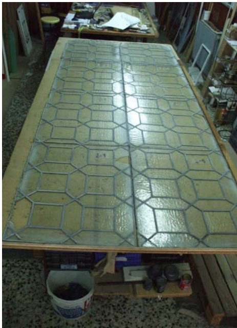
Vidriera del Cimborio del Hospital Real en el taller de restauración. Obsérvense las faltas y las piezas rotas y afectadas por abrasión en el borde del hueco.
