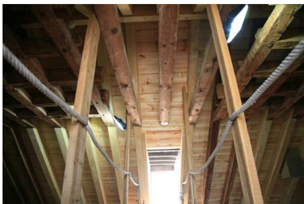
Instalación de luminarias bajo cubierta en la Catedral de Jaén.
