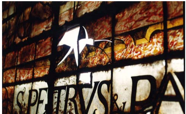
Rotura de vidrio en la Catedral de Granada.
