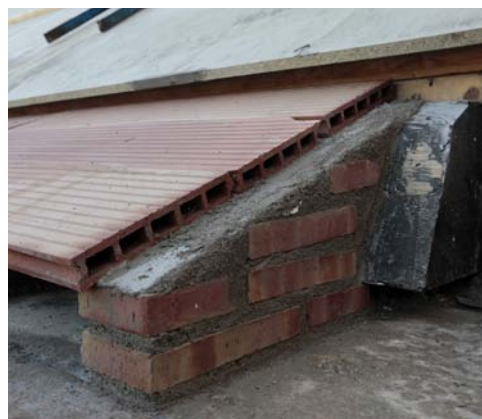
Rasillones sobre los tabiquillos. Hospital Real de Granada.
