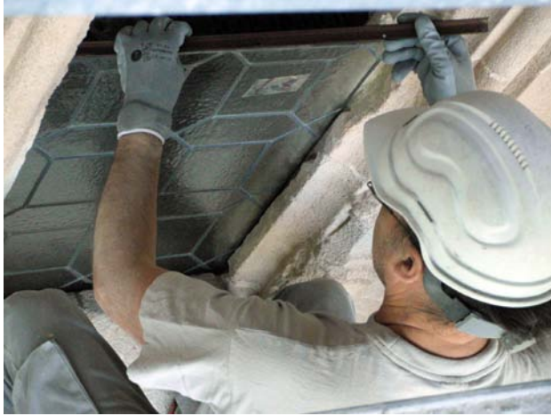
Reposición de un perfil en T de separación de paneles.
