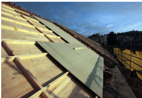
Entramado de rastreles de 60x35 mm en dos direcciones para colocación del aislante.
