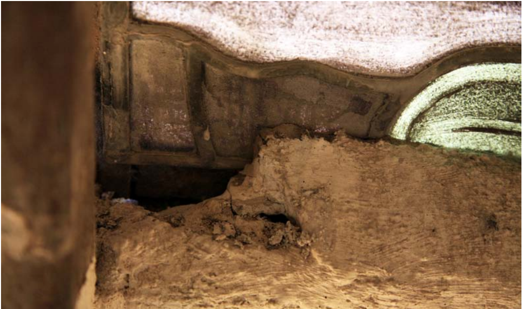
Mortero de encuentro entre vidriera y alféizar del hueco. Catedral de Granada.
