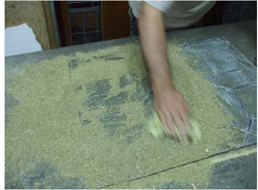
Retirada de exceso de masilla con serrín usado.
