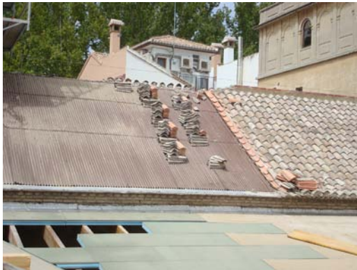
Placa ondulada bituminosa sobre un panel sándwich prefabricado colocado sobre los pares de madera. La teja se coloca sobre esta placa al modo tradicional con un mortero bastardo. Palacio de Bibataubín de Granada.
