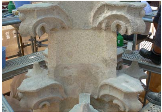
Restitución de piedra nueva. Capilla Real de Granada. FOTOGRAFÍAS: TARMA.
