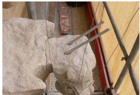
Inserción de las varillas de fibra de vi-
