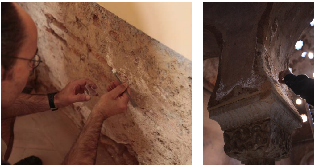
Recogida de muestras de eflorescencias salinas en el Baño Real de la Alhambra de Granada
