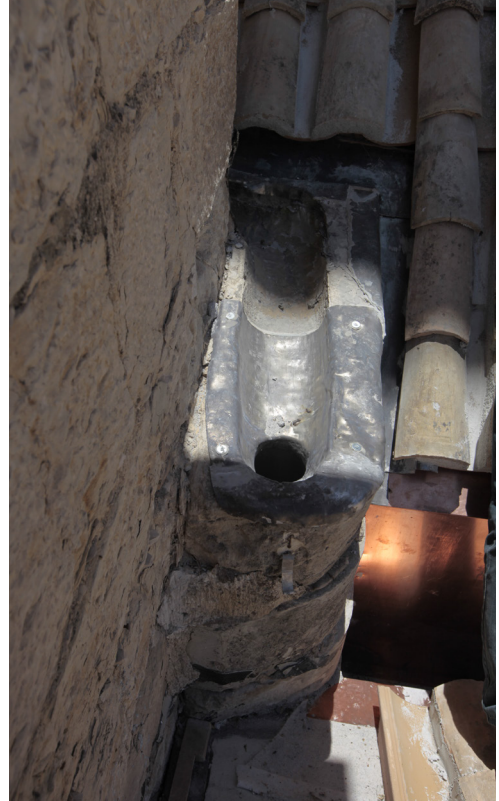
Forrado de plomo de la entrada de una bajante oculta paralela a un contrafuerte. Catedral de Jaén.
