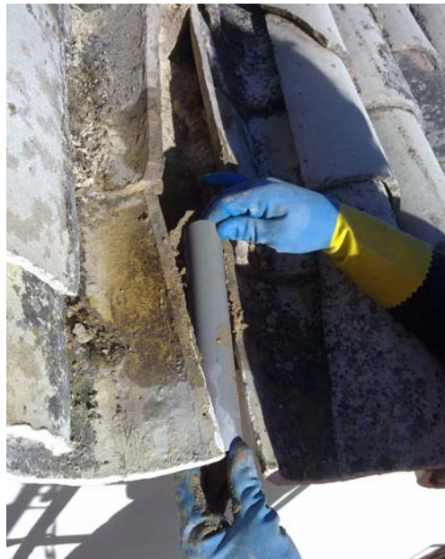
Colocación de tubo de PVC de 35 mm de diámetro. FOTOGRAFÍAS: DEMA.
