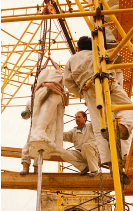
Montaje de la figura en el vástago de anclaje.
