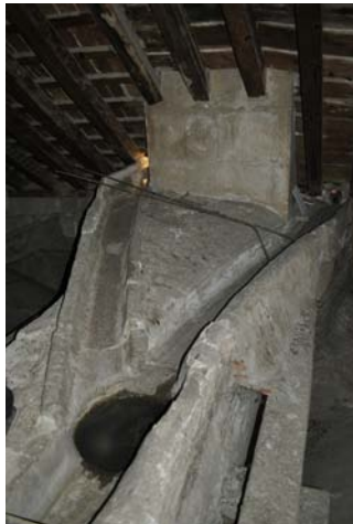
Encuentros singulares de canales y bajantes en el exterior e interior de la cubierta. Catedral de Granada.
