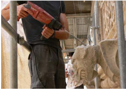
Taladro para el armado
