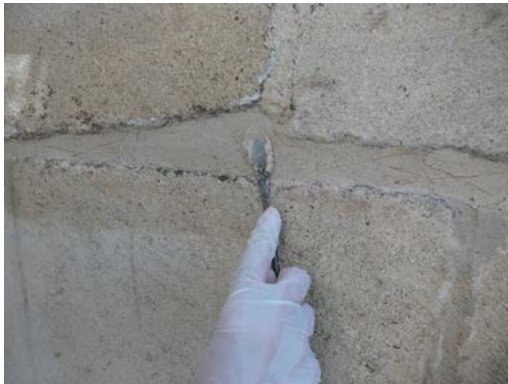
Tratamiento de llagueado con mortero de cal. Capilla Real de Granada.
