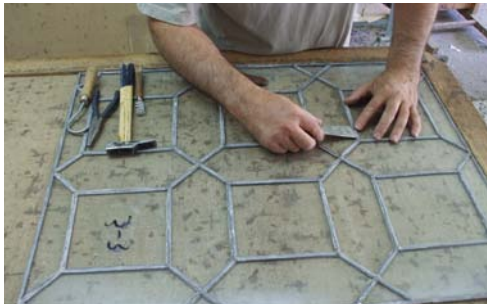
Consolidación de la matriz de plomo de las vidrieras del Címborio del Hospital Real.
