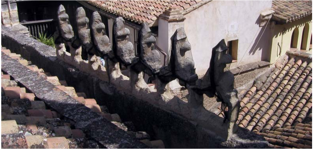
Cresterías protegidas provisionalmente con redes, debido a su fragilidad. Capilla Real, Granada.
