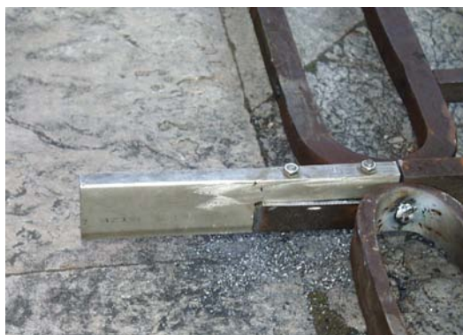
Preparación, a pie de obra, de un encastrado de acero inoxidable para recibir un paño de enrejado. Verja de la Lonja. Catedral de Jaén.
