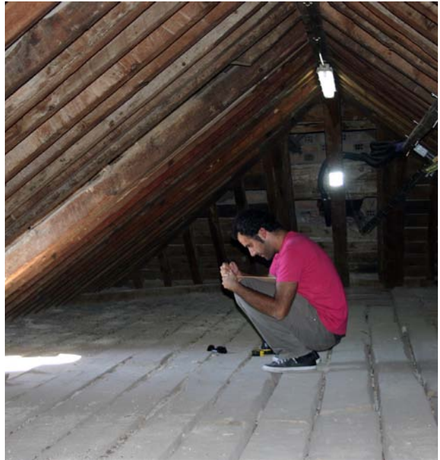
Realización de croquis de las piezas de la tronera. Palacio de las Columnas de Granada.
