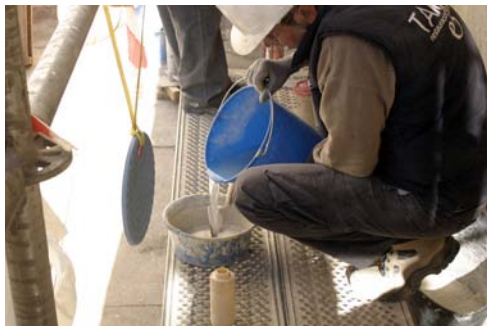
Preparación de mortero PLM Capilla Real de Granada
