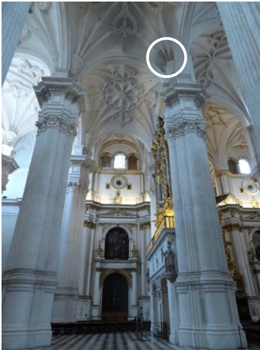
Vista general de las afecciones interiores producidas por las humedades. Catedral de Granada
