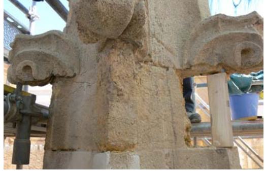
Retirada de una parte del material dañado
