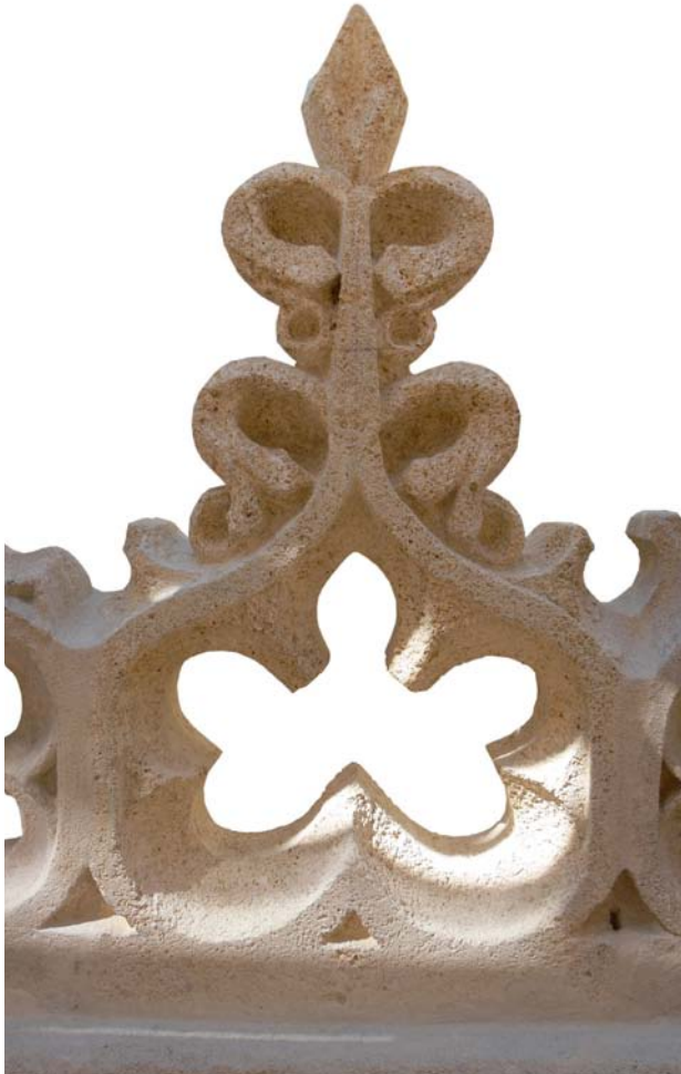
Pieza nueva de crestería colocada. Capilla Real de Granada.
