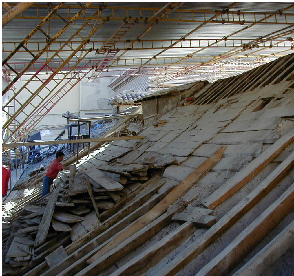
Realización de trabajos bajo sobrecubierta de estructura tubular y chapa metálica ondulada. Palacio de la Madraza. Granada 2001.
