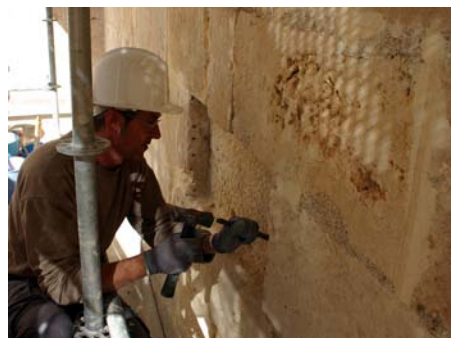
Cajeado para colocación de pieza de piedra
