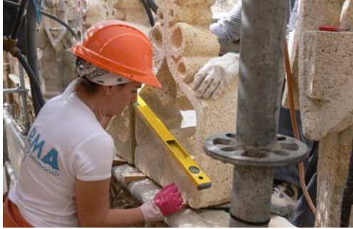
Taller a pie de obra
