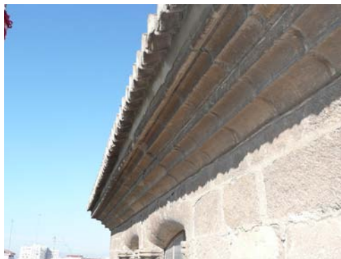
Alero de teja sobre cornisa de piedra. Hospital Real de Granada
