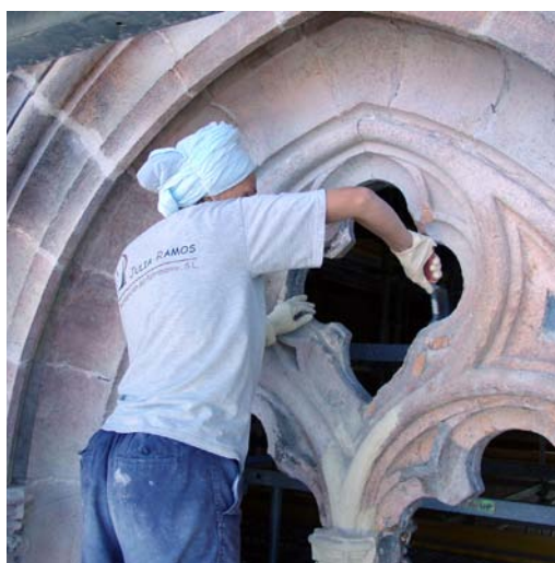
Preparación del perímetro del hueco en el Cimborio del Hospital Real.
