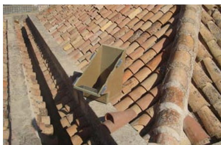
Caja nido y teja de acceso sin colocar. Cubierta de la Catedral de Jaén
