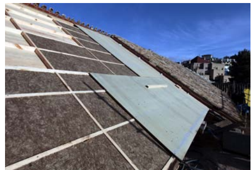
Aislamiento térmico-acústico formado por paneles de lana de roca aglomerada con resinas de 50 mm de espesor colocado sobre la tablazón.
