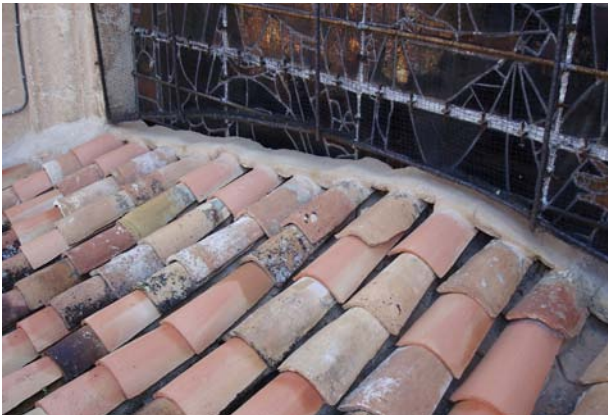
Zona de contacto entre la cubierta y la vidriera. Catedral de Granada.
