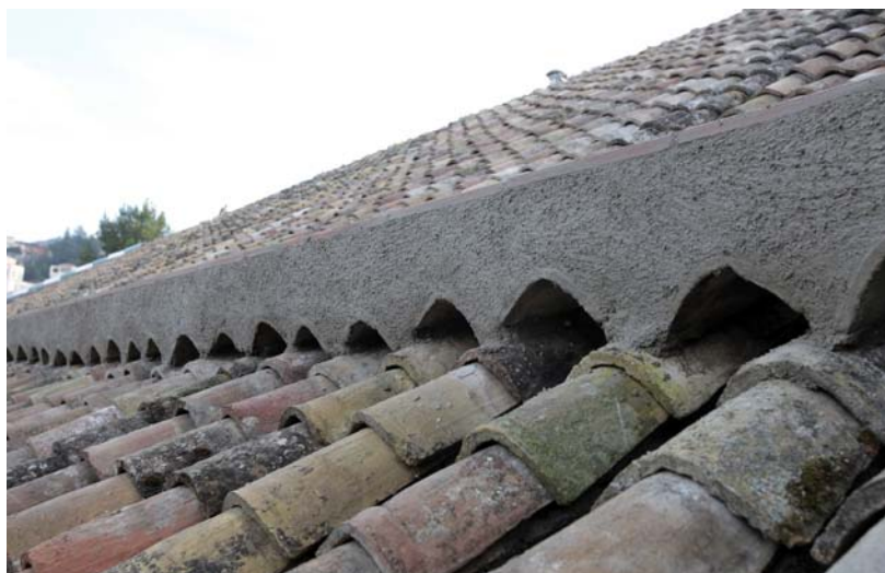
Pasarela de mantenimiento. Hospital Real, Granada.
