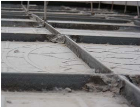
Vidriera sujeta inusualmente con masilla de pescado en el Palacio de Bibataubín
