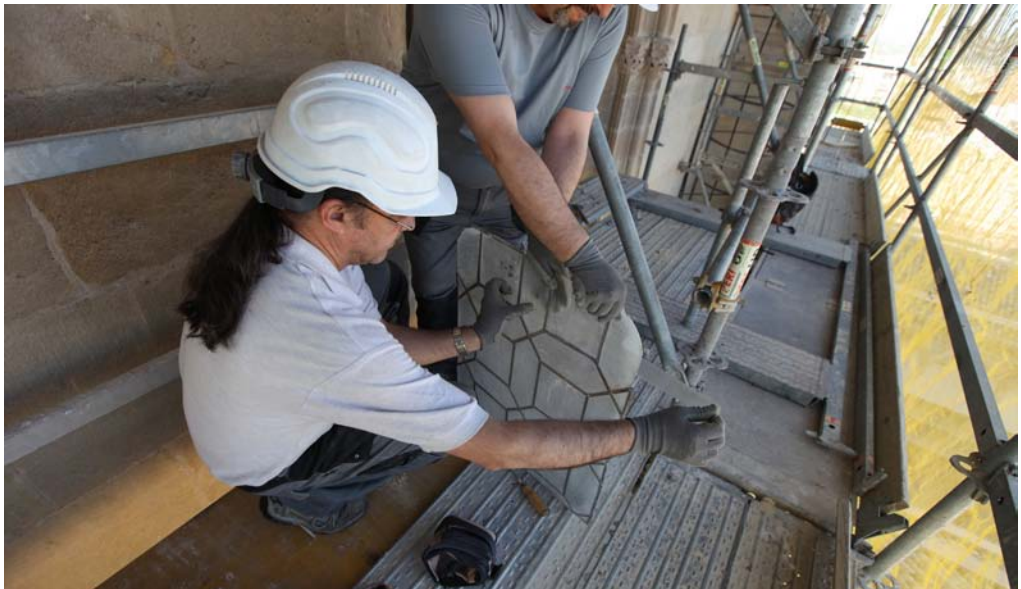
Fijación de vidrio desprendido con cinta adhesiva al retirar la vidriera. Címborio del Hospital Real
