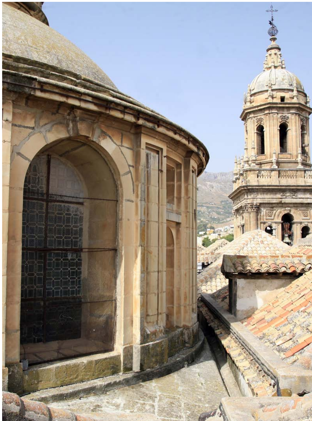
Protección de malla metálica en una vidriera. Tambor de la cúpula del transepto. Catedral de Jaén.
