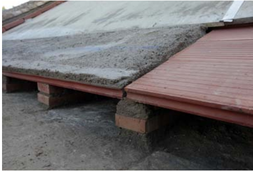
Mortero bastardo de cal y cemento sobre los rasillones. Hospital Real de Granada.
