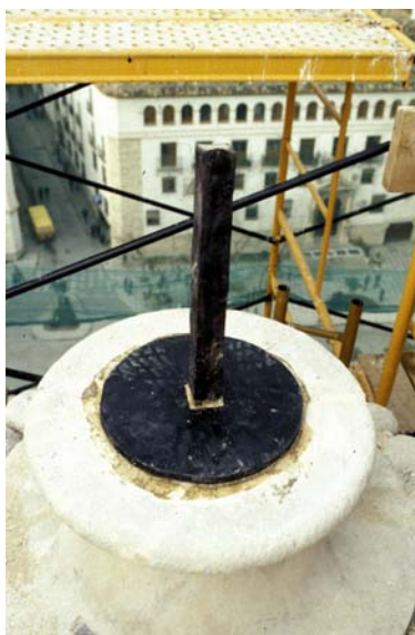
Disco de neopreno colocado sobre la base de un pináculo. Catedral de Jaén
