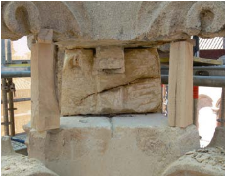
Apeo temporal con calzos de madera.
