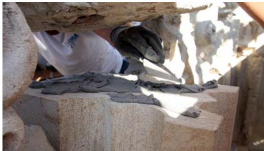
Aplicación de la resina para una unión. Capilla Real de Granada.
