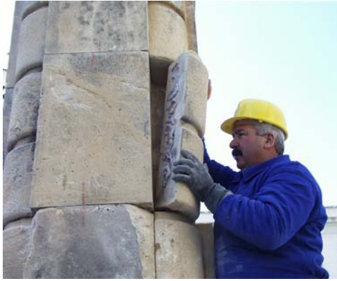
Pegado de pieza en una pilastra. Catedral de Jaén
