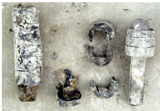
Anclajes y vástagos de hierro procedentes de los pináculos de la Catedral de Jaén. Se observa el cebado del hueco restante entre el vástago y la perforación del pináculo con plomo fundido vertido por tongadas. El plomo ha preservado al vástago de la oxidación, aunque los efectos del sismo y viento no hayan sido amortiguados a causa de la excesiva rigidez del apoyo.
