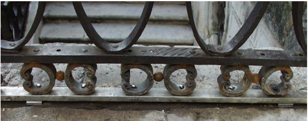
Pletina de acero inoxidable en bruto colocada en la unión de la verja con el basamento. Catedral de Jaén.
