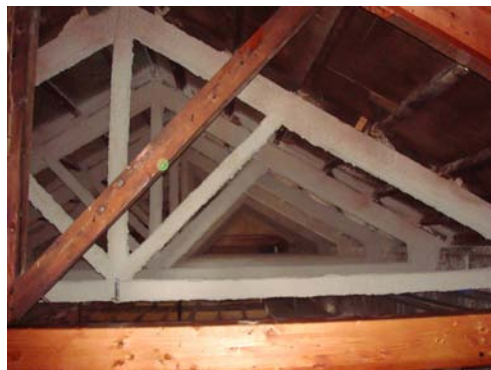
Estructura de madera protegida mediante proyectado de vermiculita-perlita con yeso. Palacio de Bibataubín de Granada.
