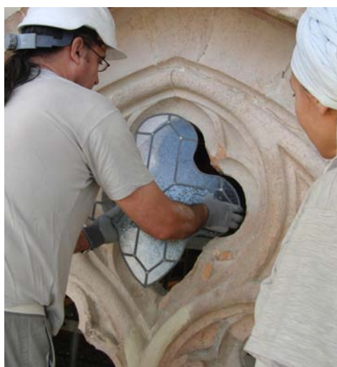
Colocación de la vidriera.
