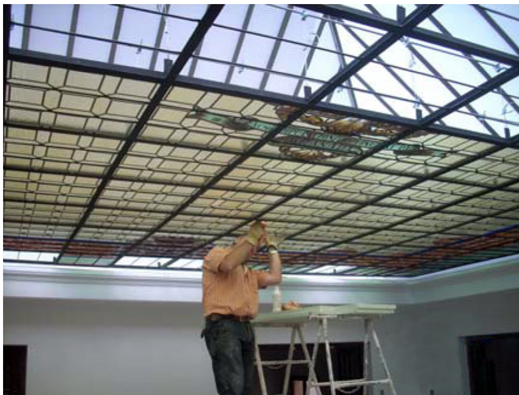
Colocación en obra de la vidriera suspendida del Palacio de Bibataubín.
