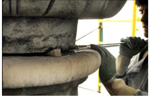
Introducción del mortero en la junta con la ayuda de una hoja de sierra. Las cuñas son provisionales y se retiran después del retacado de la junta.
