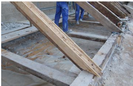
Par saneado con encofrado a la espera del vertido de mortero epoxi. Catedral de Jaén.
