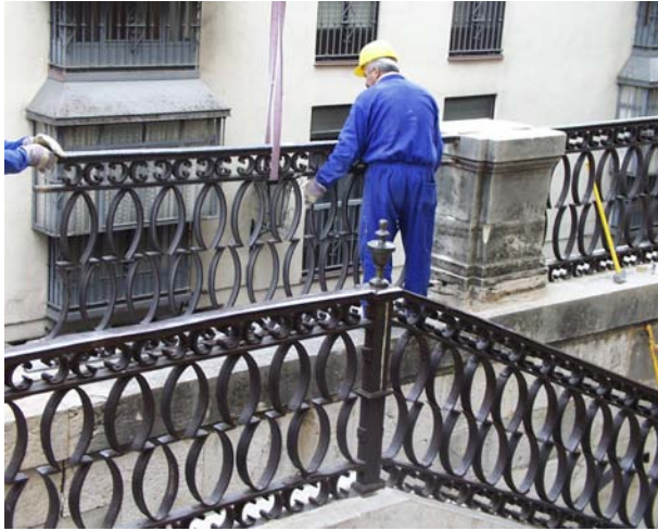
Colocación de paño de reja con ayuda de camión grúa. Catedral de Jaén.
