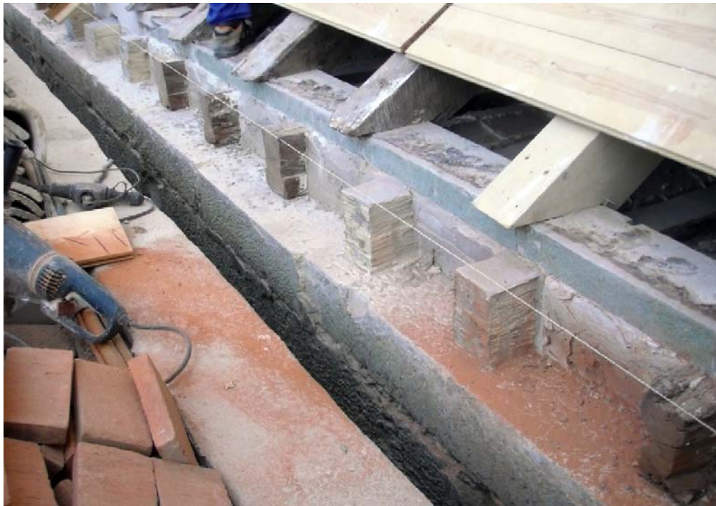
Prótesis de mortero epoxi ejecutadas en las cabezas de los tirantes. Catedral de Jaén
