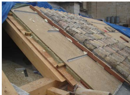
Colocación de angulares para evitar el deslizamiento de la placa cerámica prefabricada. Hospital Real de Granada
