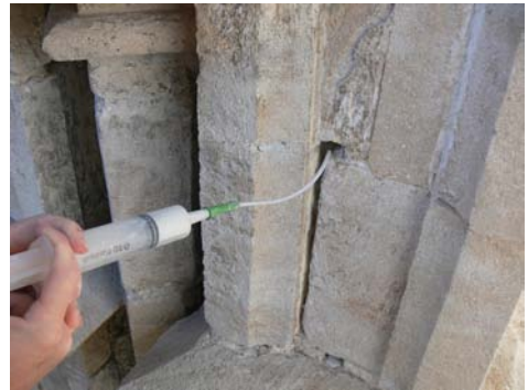
Inyección de mortero PLM en la cavidad de un pináculo. Capilla Real, Granada. FOTOGRAFÍAS: TARMA.
