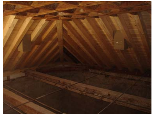
Tirantes metálicos con tensores. Catedral de Jaén.
