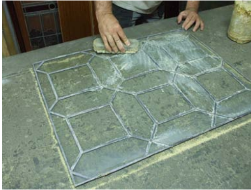
Proceso de enmasillado
