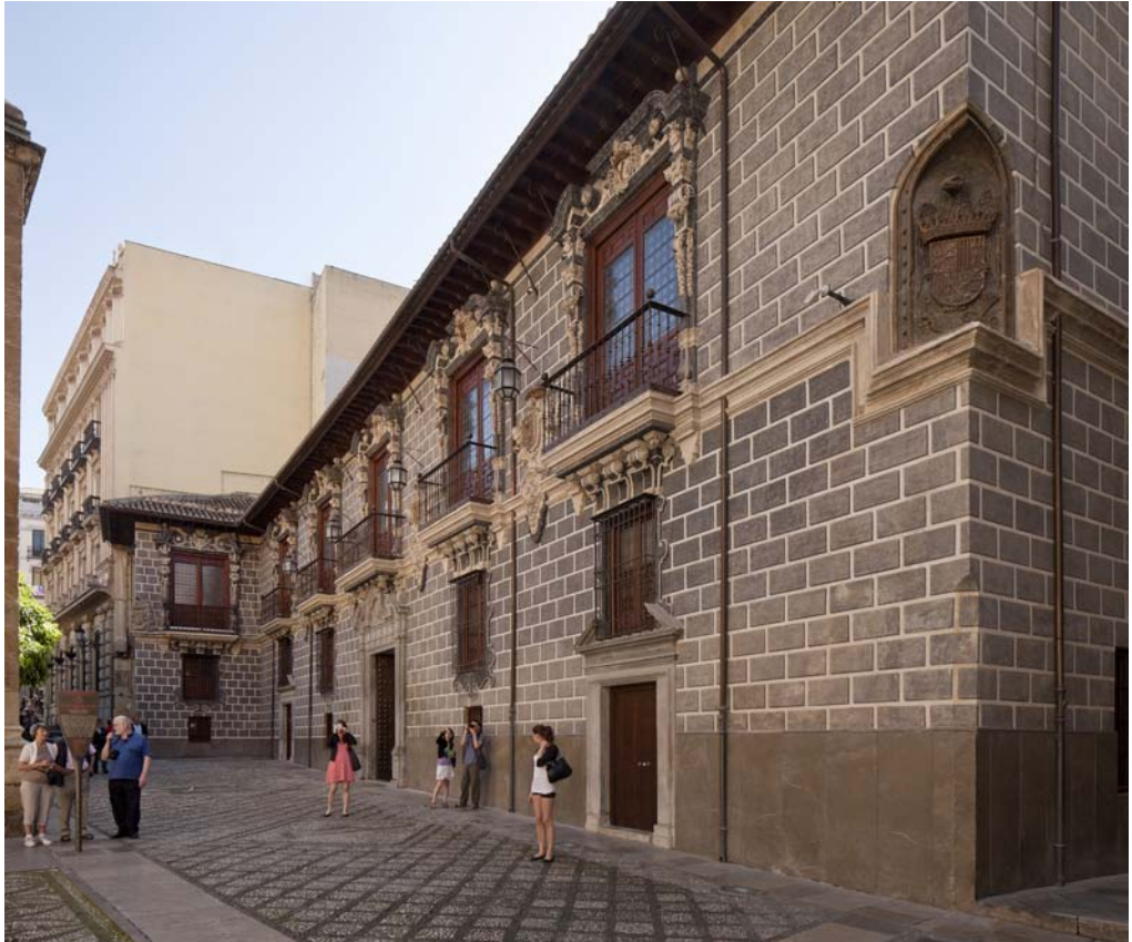
Bajantes exteriores de cobre. El sistema combinado de canales y bajantes evita la caída directa del agua en el plano inferior de fachada. Palacio de la Madraza, Granada. FOTOGRAFÍA: Fernando Alda.
