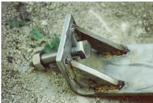
Detalle de zuncho de pletina de acero inoxidable sobre banda de neopreno y tornillos de alta resistencia.
