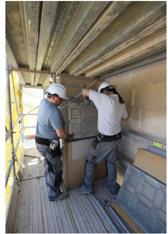
Introducción de las vidrieras del Cimborio del Hospital Real en cajas, con láminas acolchadas
