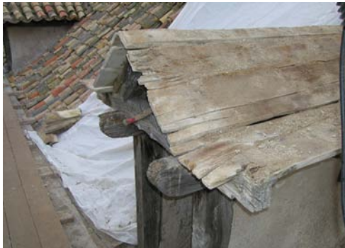
Sustitución de la armadura de tronera. Catedral de Jaén.
