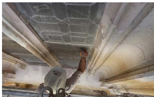
Identificación de vidrieras del Címborio del Hospital Real de Granada empleando cinta adhesiva.
