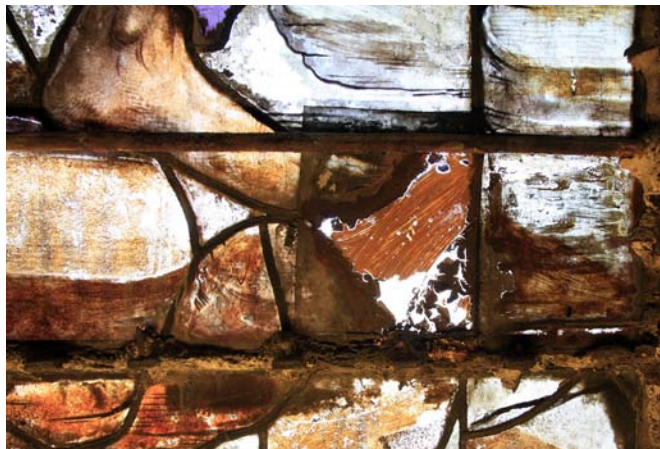
Detalle de adición de vidrio con repinte en la Catedral de Granada.
