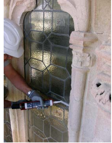
Aplicación de masilla acrílica para fijación de paneles.
