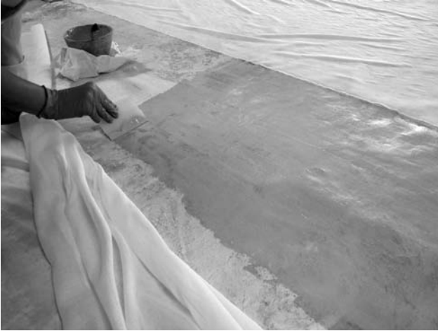
Figura 10. Colocando la Resina en el reverso del arranque
