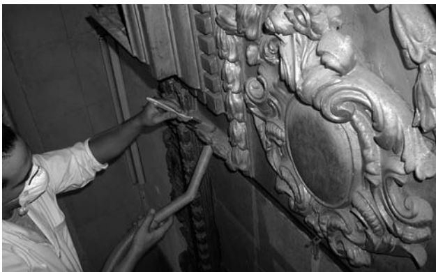
Figura 3: Limpieza por aspiración.
