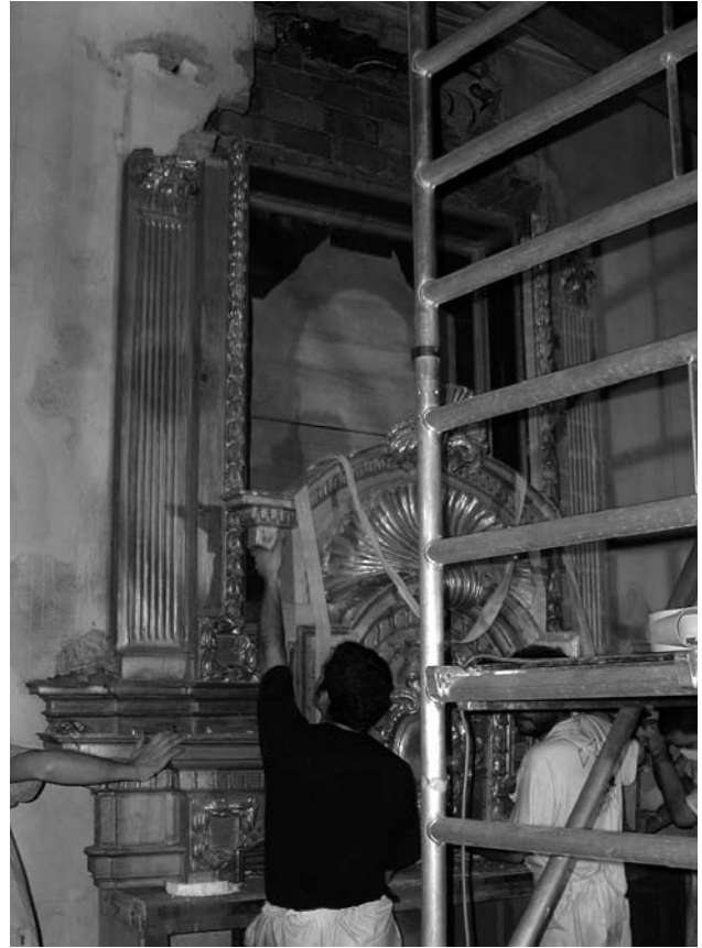
Figuras 6: Detalles del proceso de desmontaje.
