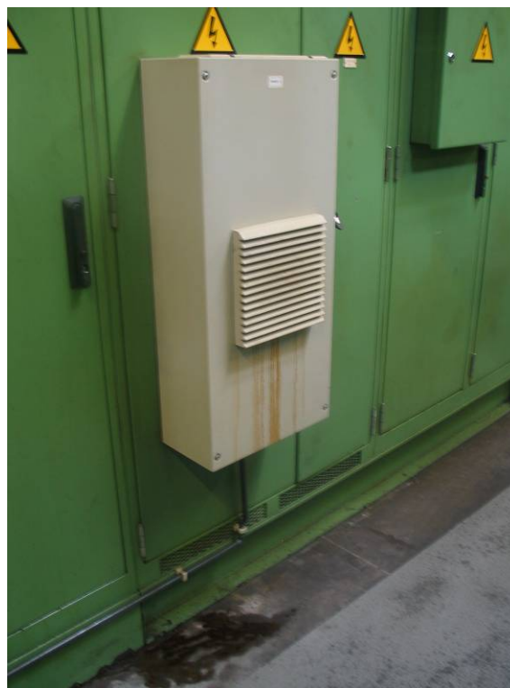
Detalle de los vahos de taladrina acumulados en los filtros de aire acondicionado.
