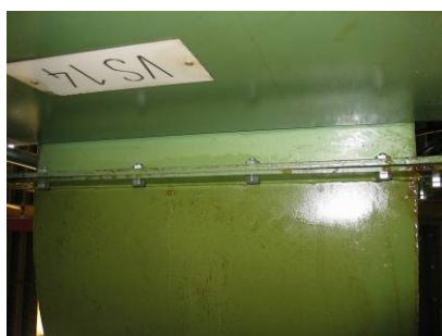
Fugas entre las juntas de la tubería de extracción
