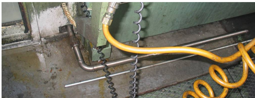
Tubo de desagüe al canal veloz, con dos giros a 90°
