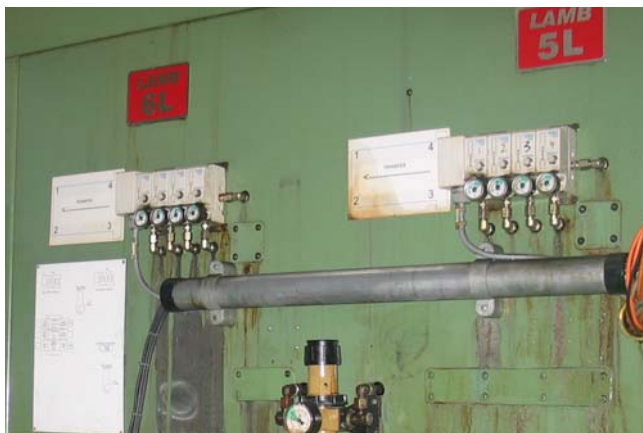
Detalle de los derrames en las estaciones 5L y 6L
