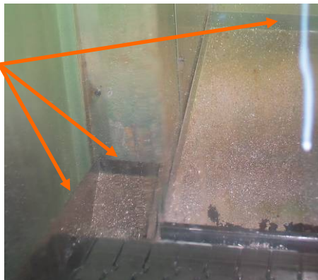
Detalle de las bandejas. Sus uniones no son estancas
