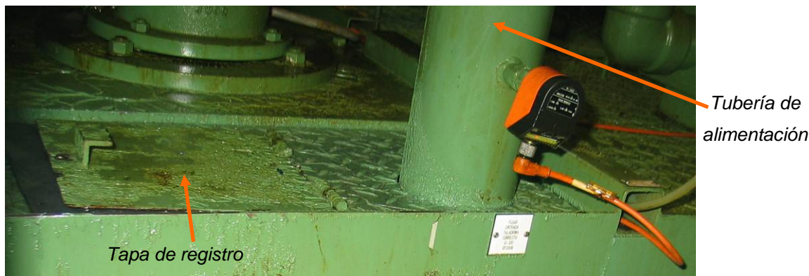
Detalle de la tapa de registro y la tubería de entrada
