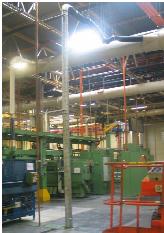
Conexión del canal veloz directamente a la aspiración.
