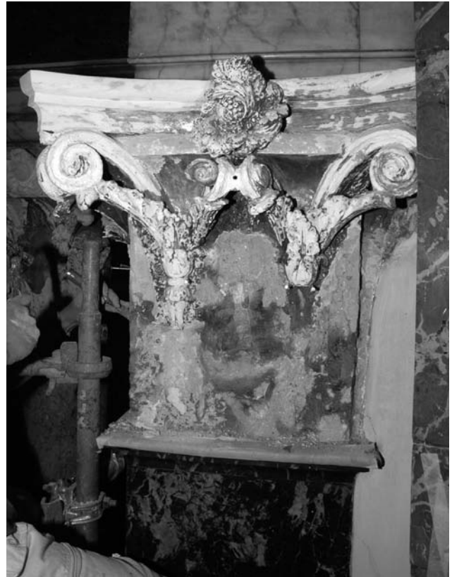
Figura 11. Eliminación del soporte irrecuperable.
