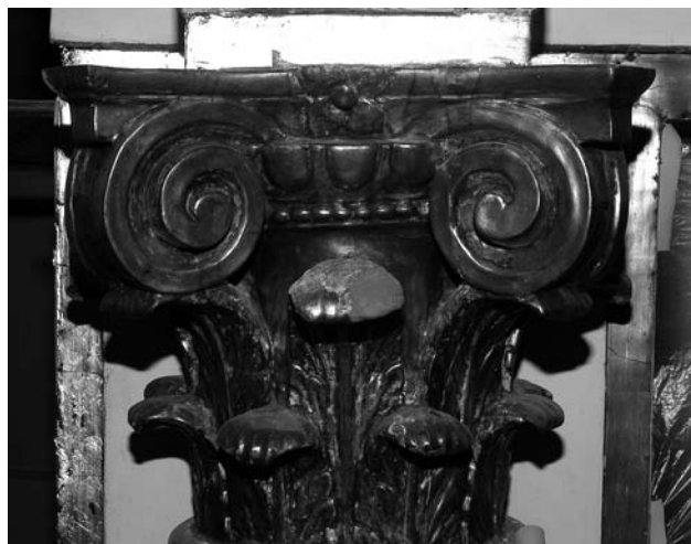
Figura 8. Limpieza de la capa metálica y colocación de anclajes para la reposición volumétrica.
