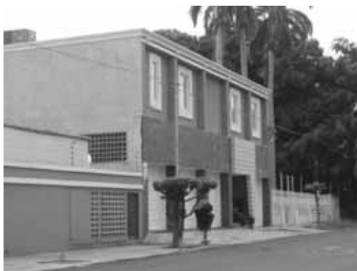
Violación de retiro de frente
