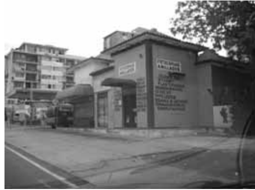
Adaptación de inmueble para uso comercial en Avenida 4 (Bella Vista)
