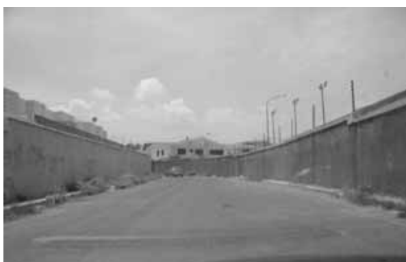
Calle entre Villas, sector El Pilar
