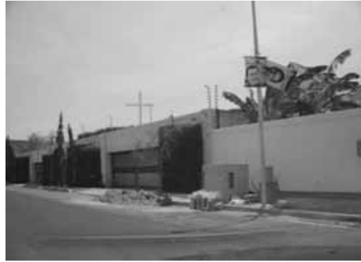
Urbanización Monte Claro; violación de retiro de frente y cambio de uso a equipamiento religioso Urbanización El Pilar
