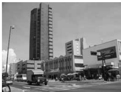
Calle 77 (5 de Julio), sustitución de inmuebles por nuevas edificaciones comerciales y por torre aislada en altura
