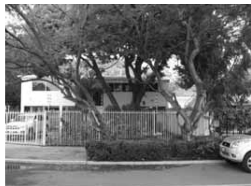
Urbanización La Estrella; violación de retiro lateral Urbanización Irama
