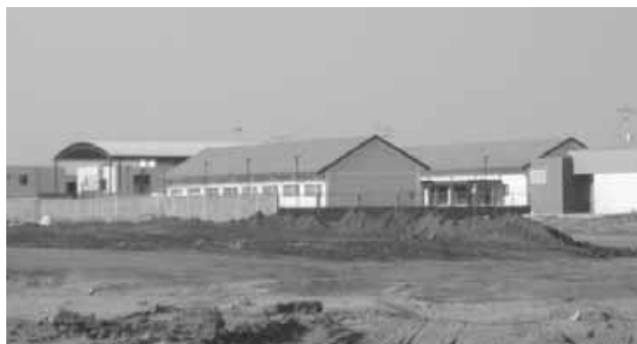
Infraestructura de servicios. Barrio Ciudad Lossada
