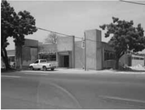
Cambio de usos y violación de ambos retiros de frente
