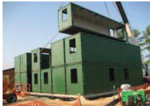
Imagen 5.2.a. Ejemplos del uso de contenedores en la construcción.
