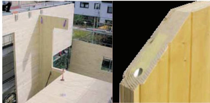
Imagen 5.2.2.j. Paneles mixtos aplicados a construcción.
