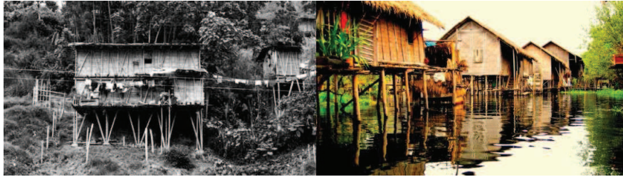
Imagen 6.2.2.1.b. Ejemplos de viviendas sobre postes en zonas lluviosas.
