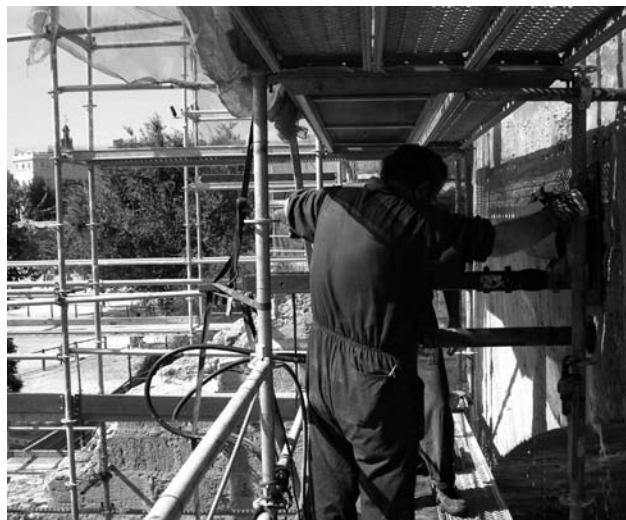
Imagen 8 Haciendo una perforación en el puente.
