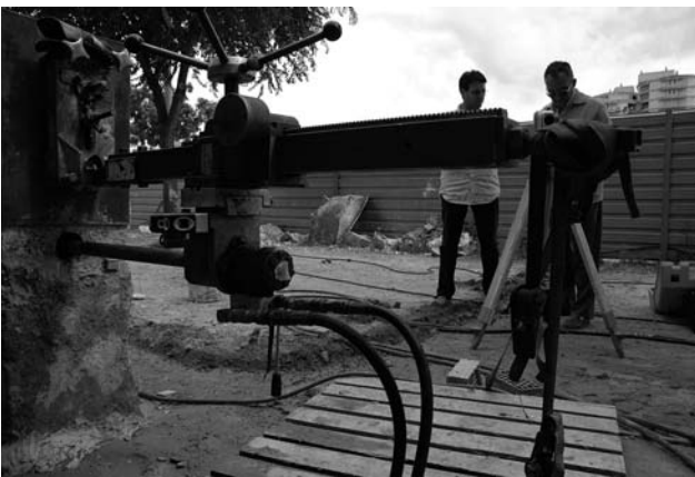
Imagen 2 Taladro con el colimador de laser.
