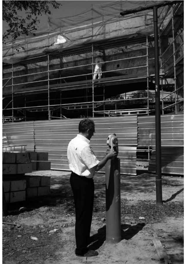
Imagen 6 Base de replanteo aguas abajo.
