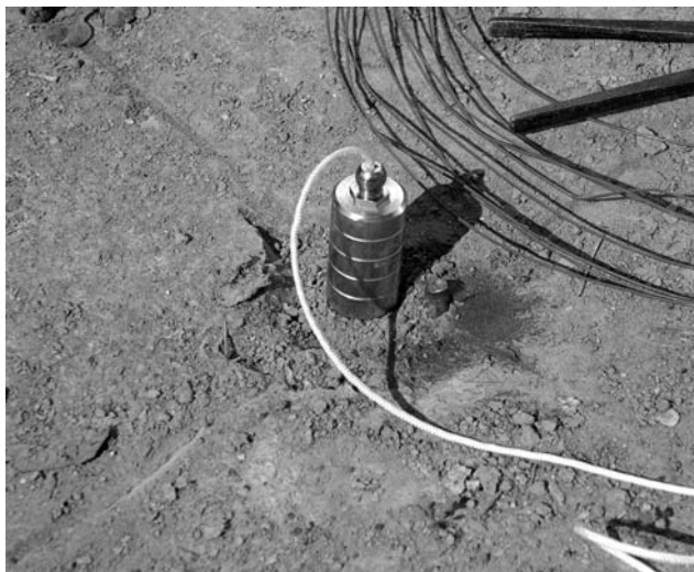
Imagen 7 Punto replanteado en el suelo para situar en su vertical la referencia de perforación.
