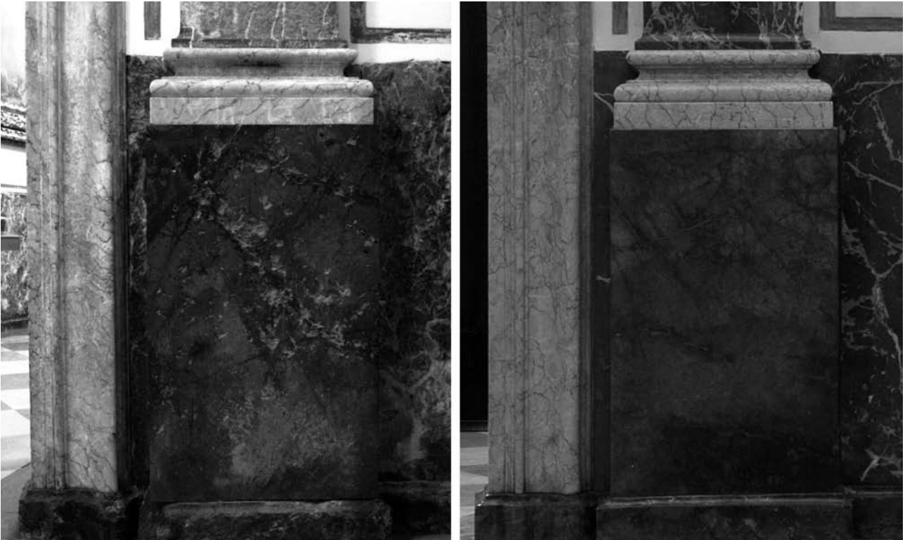
Figura9. Zócalo de mármol de Náquera, antes y después de la intervención.
