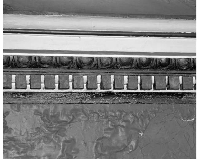
Figura4. Abolsamientos producidos por la descohesión de las capas del estuco.
