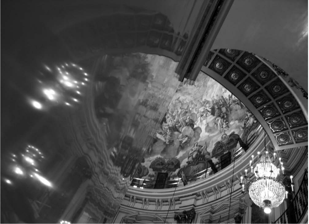
Figura13. Imagen del estuco una vez restaurado.
