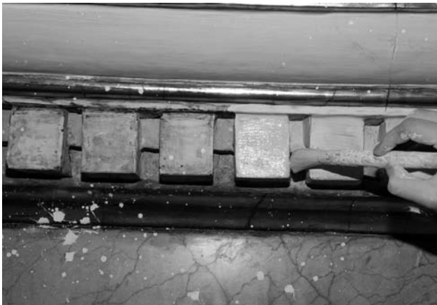
Figura12. Aplicación de la técnica del estuco a la brocha.
