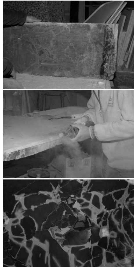
Figura8. Proceso de consolidación, refuerzo y restitución volumétrica del zócalo Royo de Aspe.
