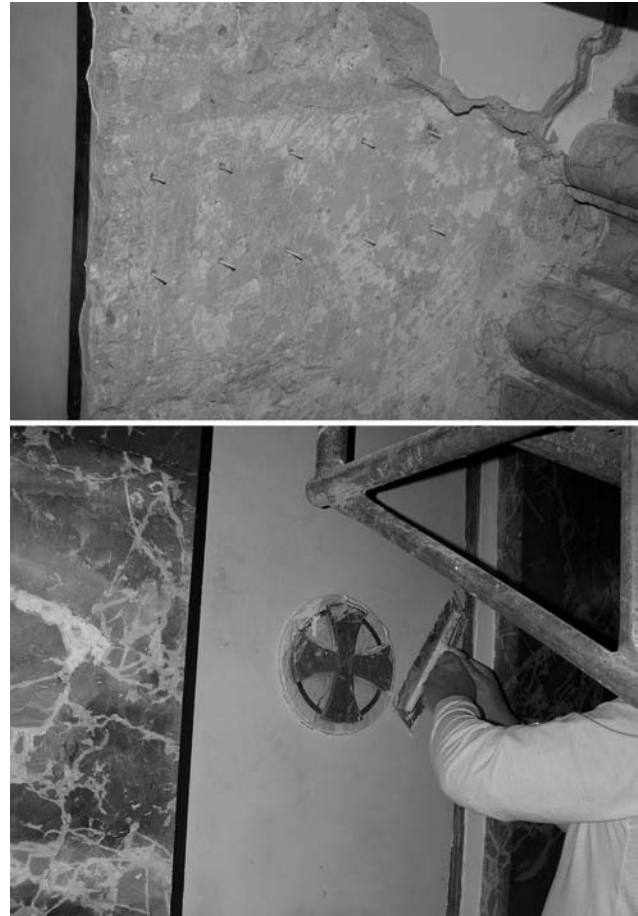
Figura11. Proceso de restitución de las capas internas del estuco..
