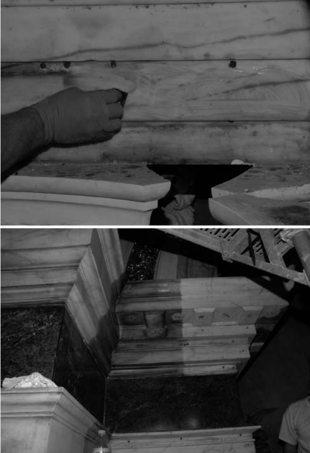
Figura7. Limpieza química mediante jabón neutro, en los mármoles..
