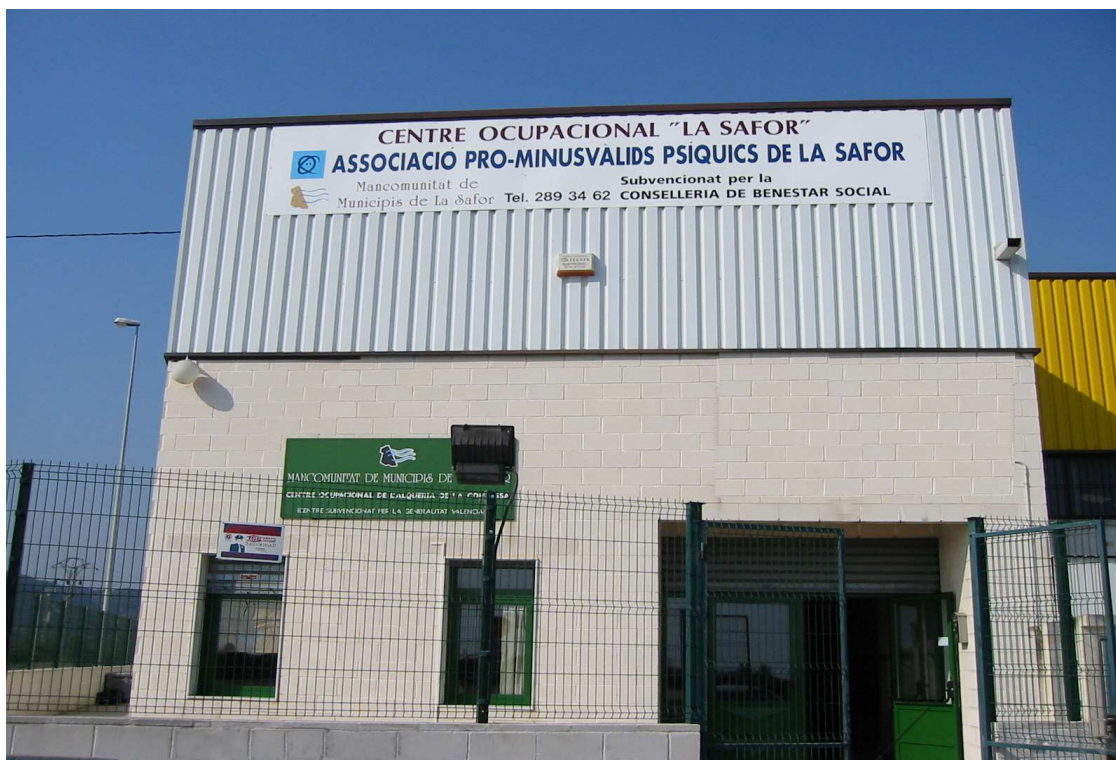
Figura 3: Entrada Centro Ocupacional La Safor. Fuente: Elaboración propia.
