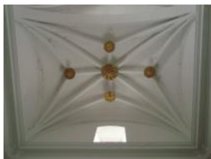
Bóveda de Crucería
