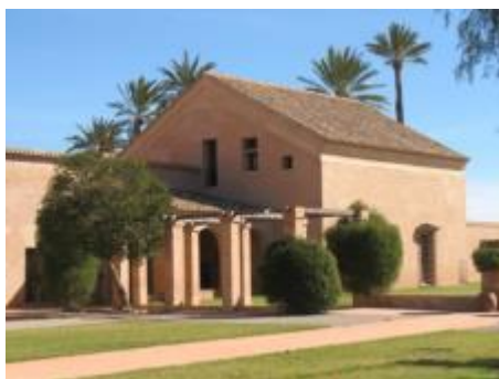
6. Celda del Prior
