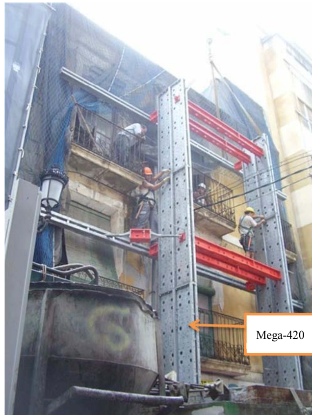
Ensamblaje de elementos MEGA-420 (Fotografía 10)
