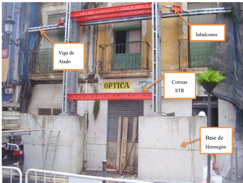
Detalle de la cimentación y montaje de la estructura (Fotografía 8)
