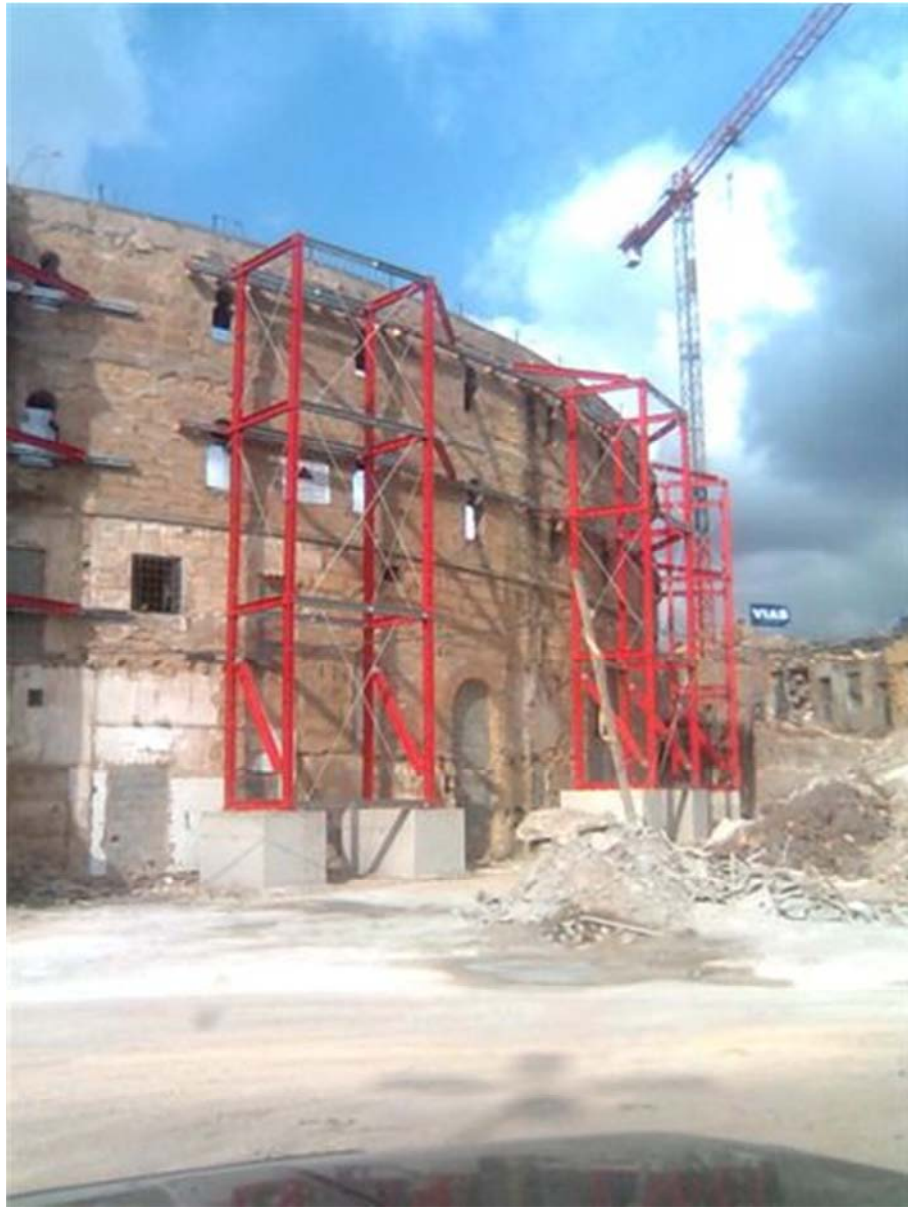
Zona de estructura a base de vigas STR (Fotografía 19)
