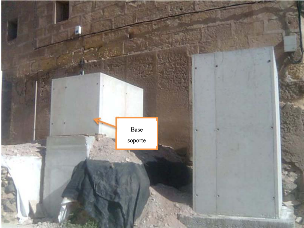
Detalle de cimentación de la estructura (Fotografía 17)
