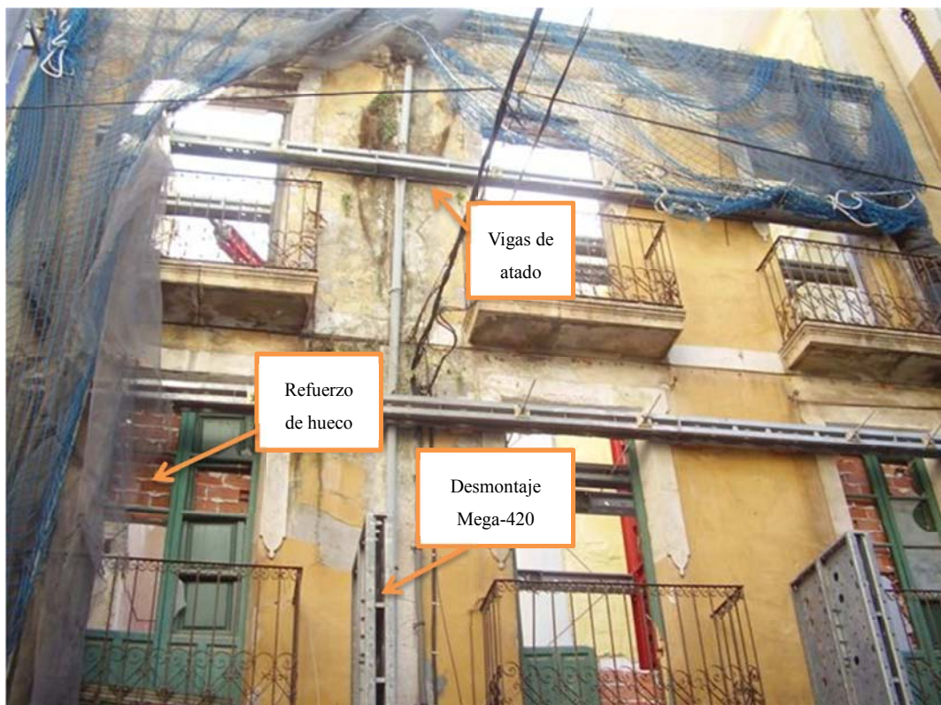
Vista exterior de la fachada una vez desmontado el apeo exterior (Fotografía 16)
