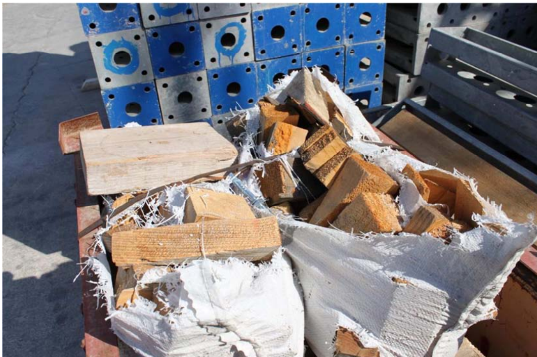
Piezas de madera para ajuste de elementos contra fachada (Fotografía 5)
