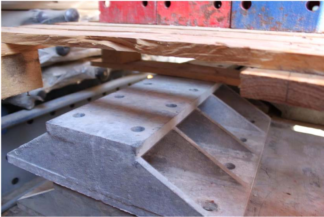
Placa de anclaje de cimentación (Fotografía 6)
