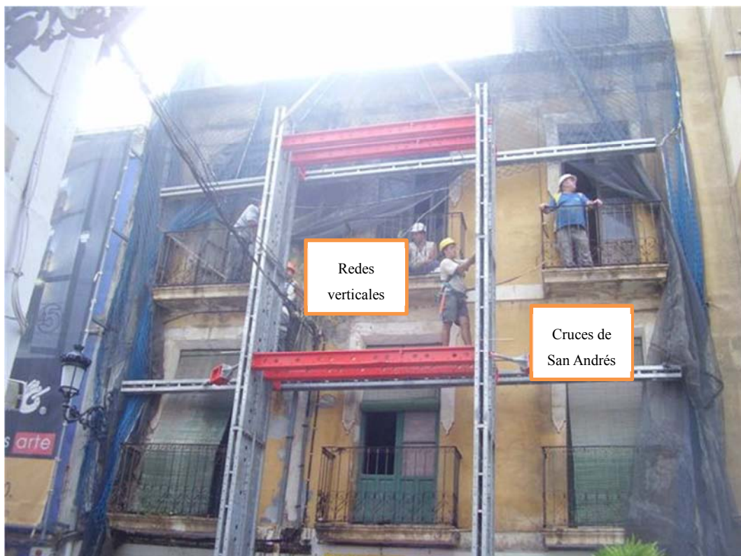
Vista completa del sistema Soldier con apeos industrializados (Fotografía 12)
