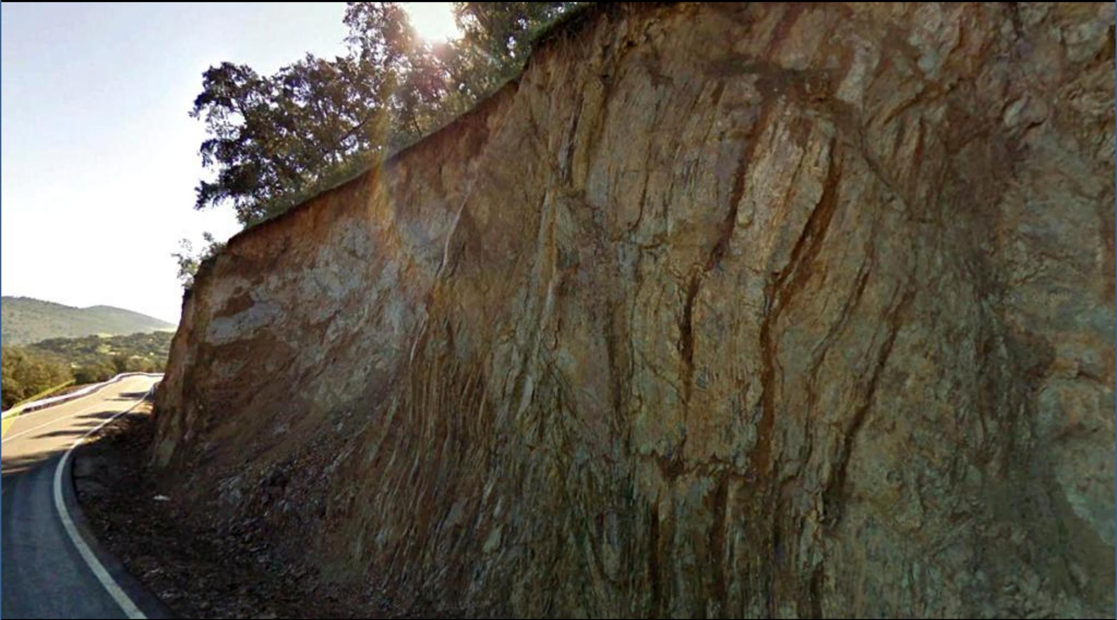
Inestabilidad de talud favorecida por la tectónica de los materiales del Cámbrico Inf. SE de la Sierra del Molino. NE Hoja de Burguillos del Cerro.
