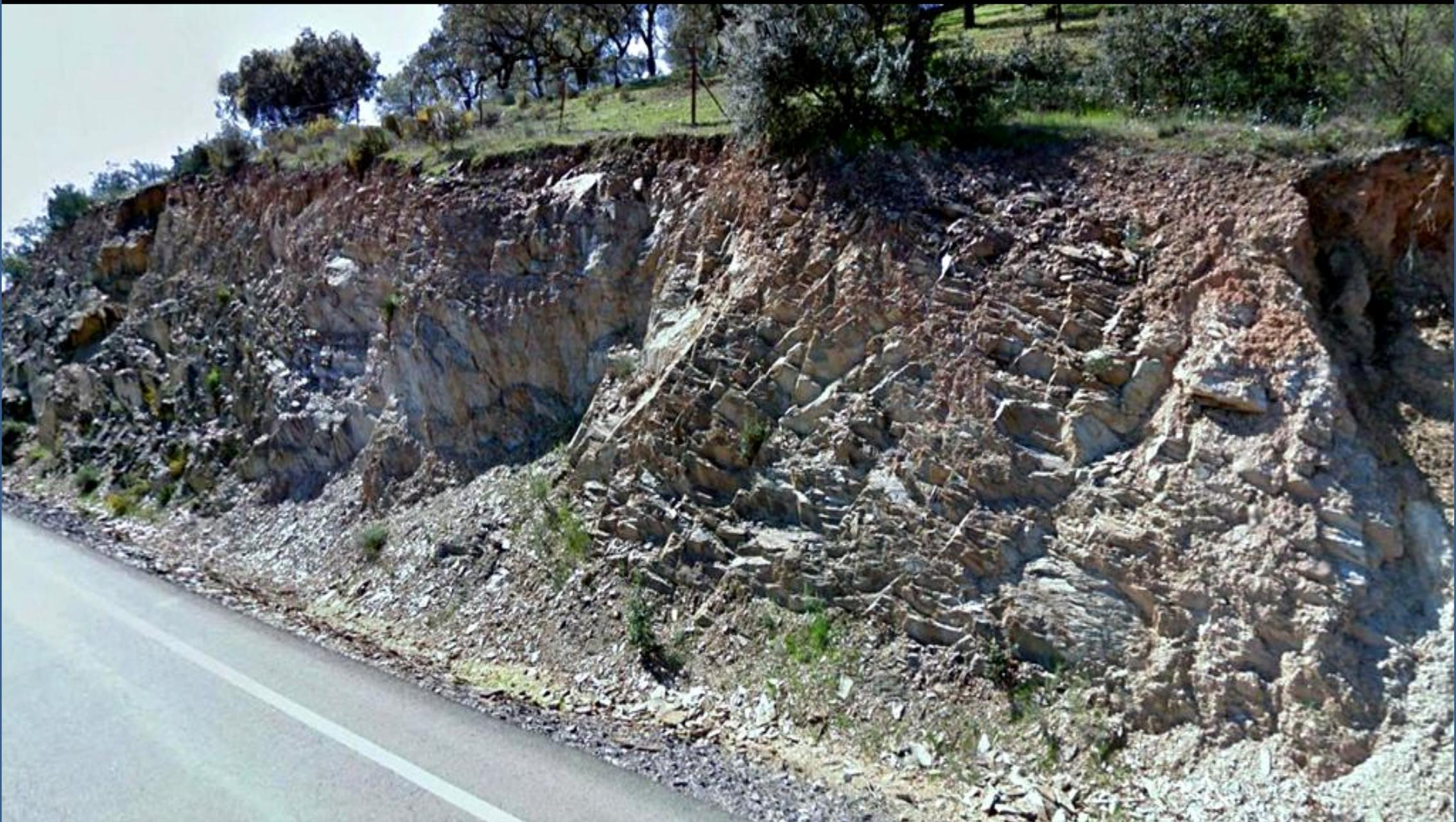
Inestabilidades en los taludes de pizarras, ampelitas y liditas del Silúrico en el S de Villanueva del Fresno. SW Hoja. Badajoz.
