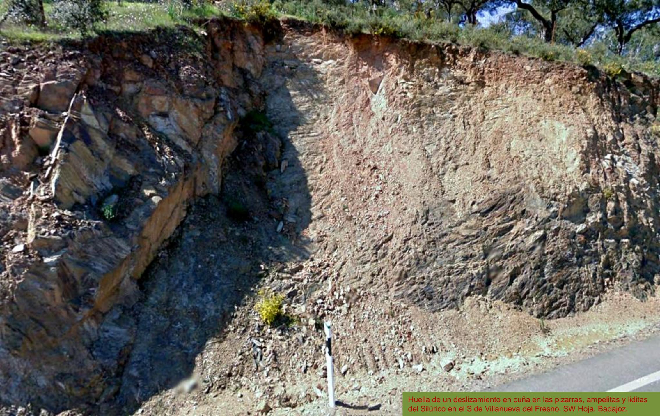
Huella de un deslizamiento en cuña en las pizarras, ampelitas y liditas del Silúrico en el S de Villanueva del Fresno. SW Hoja. Badajoz.
