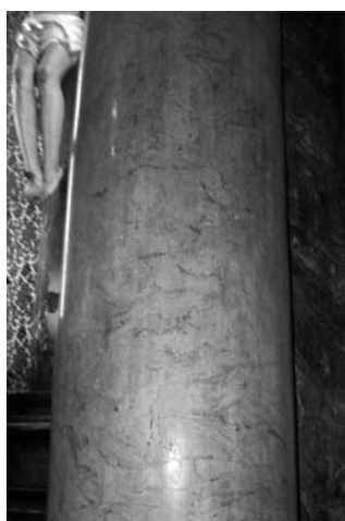
Figure 3. Buixcarró rosa. Column within Basílica de la Virgen de los Desamparados (Valencia).
