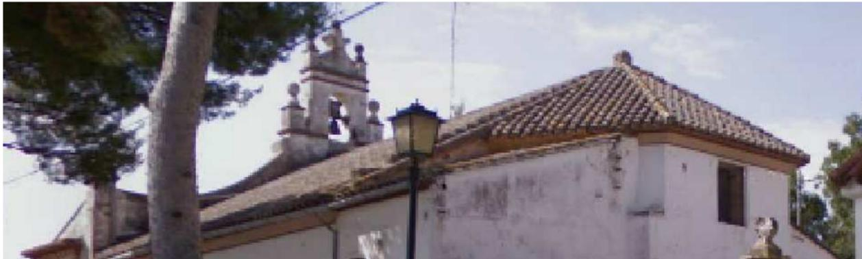
La cubierta apoya sobre tabiquillos en la zona de la nave central, y éstos descargan en la bóveda. Sobre los tabiquillos se colocan los bardos cerámicos y sobre éstos se colocan las tejas cerámica curva, teja árabe. En la zona de las naves laterales los bardos apoyan en correas de maderas.
