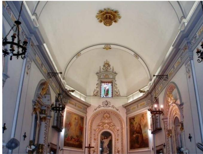
Sobre las **naves laterales** tenemos **bóvedas tabicadas** de ladrillos que apoyan sobre los muros y contrafuertes. Deben de tener 2 o 3 hojas trabadas para transmitir correctamente las cargas, y sobre éstas se dispondría una capa de mortero que servía de nivelación para el pavimento de la planta superior.
